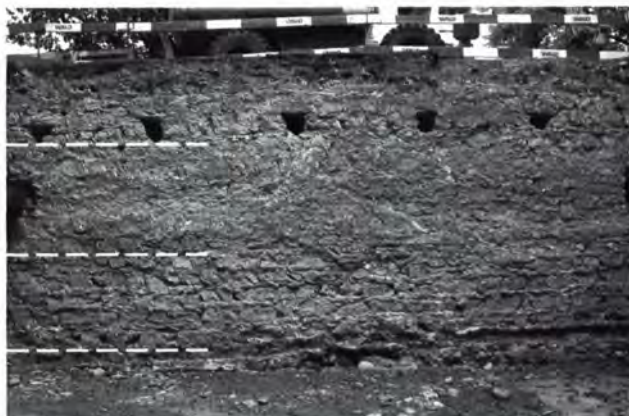
Abb. 28. Basel, Klingentalgraben 28. Ansicht der Rückseite der äusseren Grabenmauer nach dem Abtragen des Walls. Die gestrichelten Linien deuten die drei Bautappen an. An der Basis der obersten Etappe ist eine Reihe von Gerüstbalkenlöchern zu erkennen. Foto ABBS.
