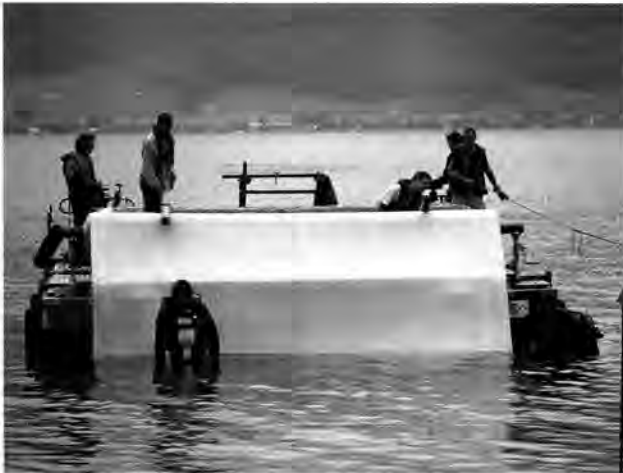
Abb. 4. Sutz-Lattrigen BE, Hauptstation. Verlegen des Geotextils (links) mit Hilfe des eigens für die Schutzmassnahmen gebauten Katamarans mit verklappbarem Jalousieboden für das Einbringen der Kiesschüttung (rechts).
