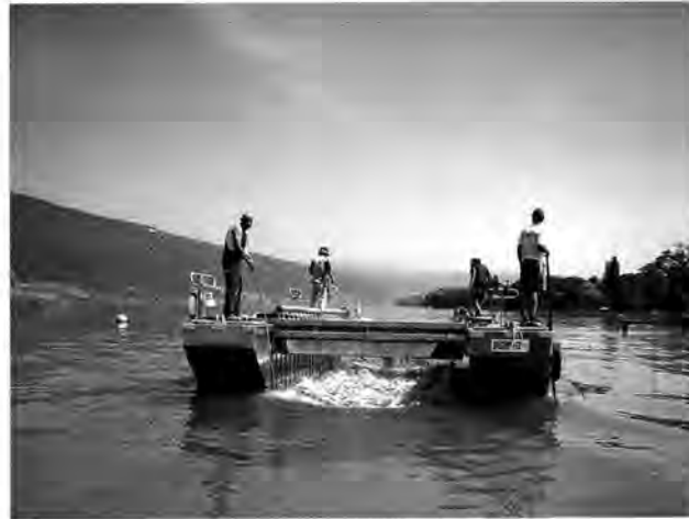
Abb. 4. Sutz-Lattrigen BE, Hauptstation. Verlegen des Geotextils (links) mit Hilfe des eigens für die Schutzmassnahmen gebauten Katamarans mit verklappbarem Jalousieboden für das Einbringen der Kiesschüttung (rechts).
