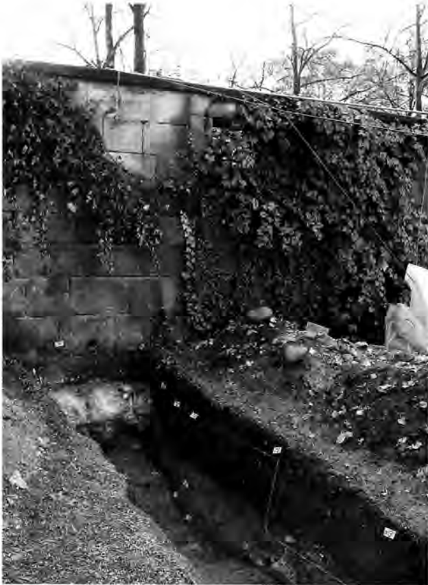
Abb. 11. Zürich ZH-Lindenhof. Nordabschnitt der Terrassen-Stützmauer, Blickrichtung Süden. Im Vordergrund ein Teil der Sondierung vom Sommer 2002. Die Stützmauer stammt in diesem Abschnitt aus dem 14. Jh. und wurde im 18./19. Jh. neu mit Sandstein verblendet. Darunter hell eine Steinreihe der ursprünglichen Mauerschale und darunter, schwach sichtbar, ein paar Steine der römischen Mauer. Im Graben der neuzeitliche Humus und darunter Reste von Gruben aus der Spätlatène-Zeit sowie die anstehende Moräne. Photo Stadtarchäologie Zürich.
