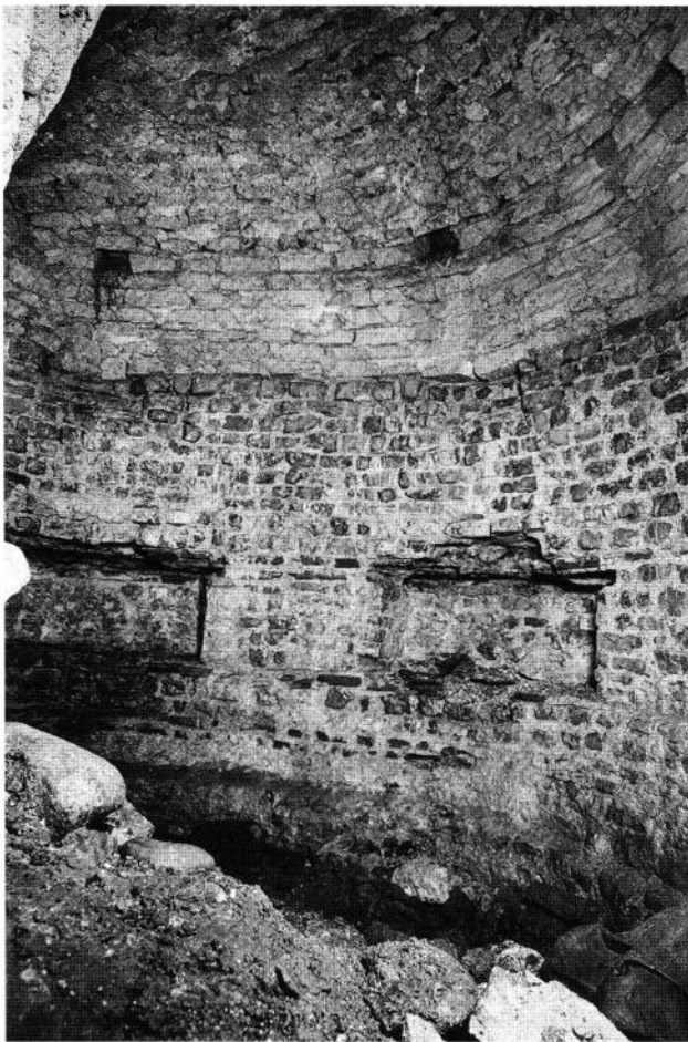
Abb. 15. Augst BL, E. Frey AG. Unterirdisches Gewölbe. Blick aus der Tunnelmündung in das Gewölbe. Im Hintergrund zwei der insgesamt drei Nischen in der Wandung, darüber in der Überkuppelung drei Luftschächte. Photo A. Fischer.
