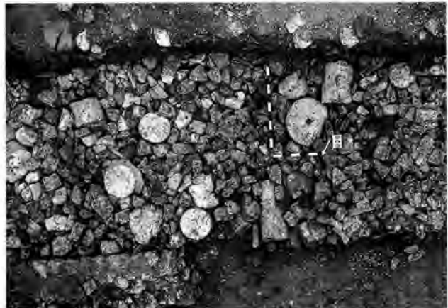
Abb. 11. Kastelen. Aufsicht auf die weitgehend aus Spolien bestehende Fundamentstücker der spätrömischen Befestigungsmauer. Photo: G. Sandoz.
