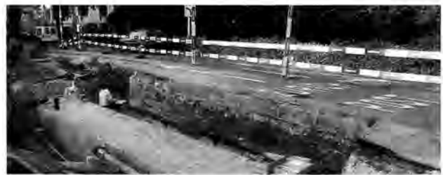
Abb. 4. Zug ZG, Vorstadt. Der ausgehobene Leitungsgraben zeigt im Profil eine jungsteinzeitliche, schwarze Kulturschicht.
