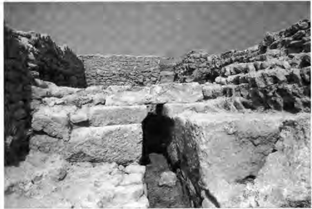
Fig. 31. Orbe VD, Boscéaz. Canalisation servant à l'écoulement des eaux du petit bassin des thermes, constituée de deux murets recouverts de dalles de molasse et dont le fond est tapissé de tegulae.
