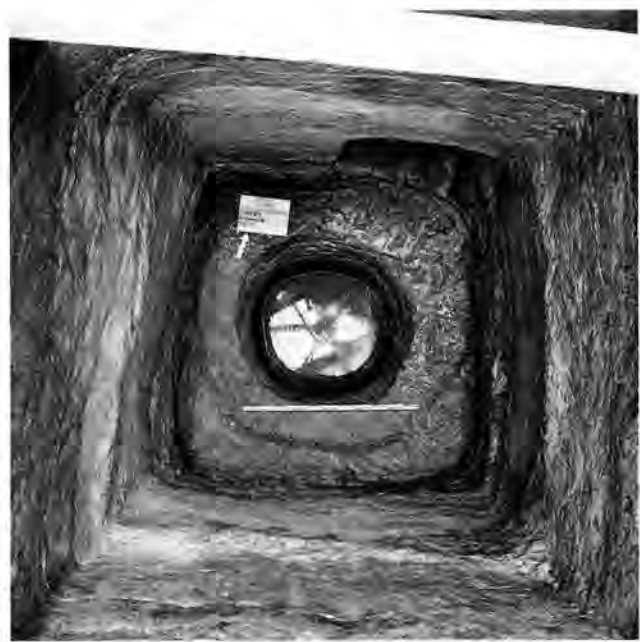
Abb. 32. Studen BE, Vorderberg, Petinesca. Blick in den unteren, in den anstehenden Sandstein eingetieften Teil des Brunnenschachtes III.
