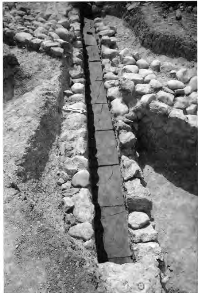
Fig. 30. Orbe VD, Boscéaz. Fondations massives des pièces au passage du grand collecteur est-ouest. L'emploi de blocs d'architecture en cours de façonnage est remarquable.
