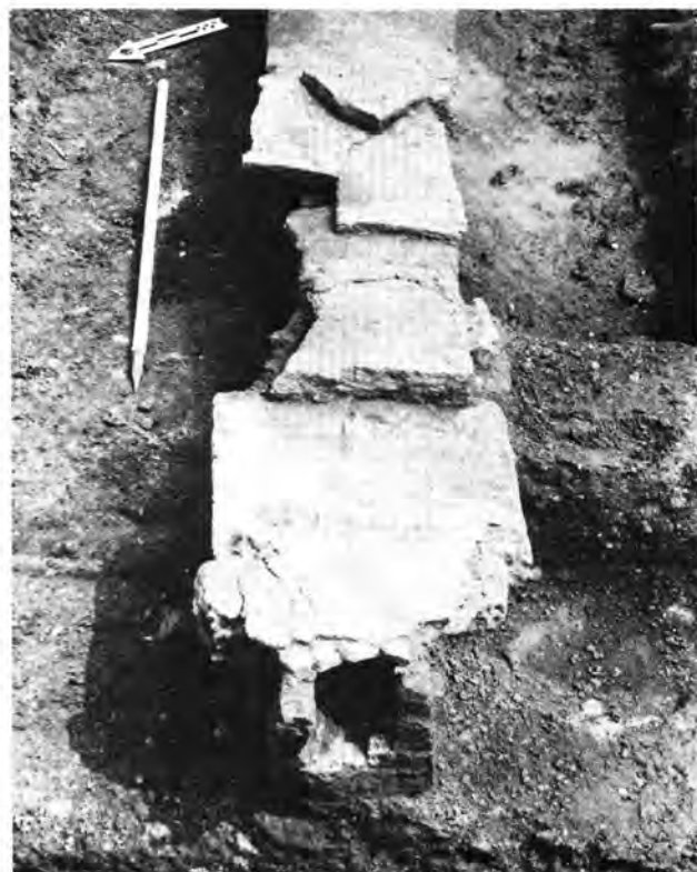
Fig. 10. Orbe VD, Boscéaz. Trois exemples de canalisations découvertes en 1987: a) conduit de maçonnerie couvert par des tegulae et des imbrices (flèche), se jetant dans le collecteur principal voûté. b) canal formé d'éléments de terre cuite en U, emboîtés et couverts de tegulae retournées. c) vue à l'intérieur du collecteur principal.
