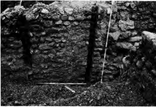
Fig. 53. Nyon VD, La Morache. Bâtiment B: mur ouest de S1, traces de poutres (fig. 52, 1).
