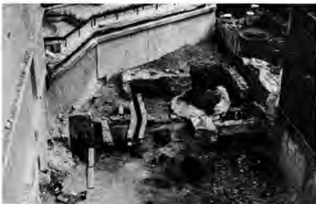
Fig. 60. Nyon VD, Rue de la Gare 9. Vue d'ensemble du chantier depuis le sud.
