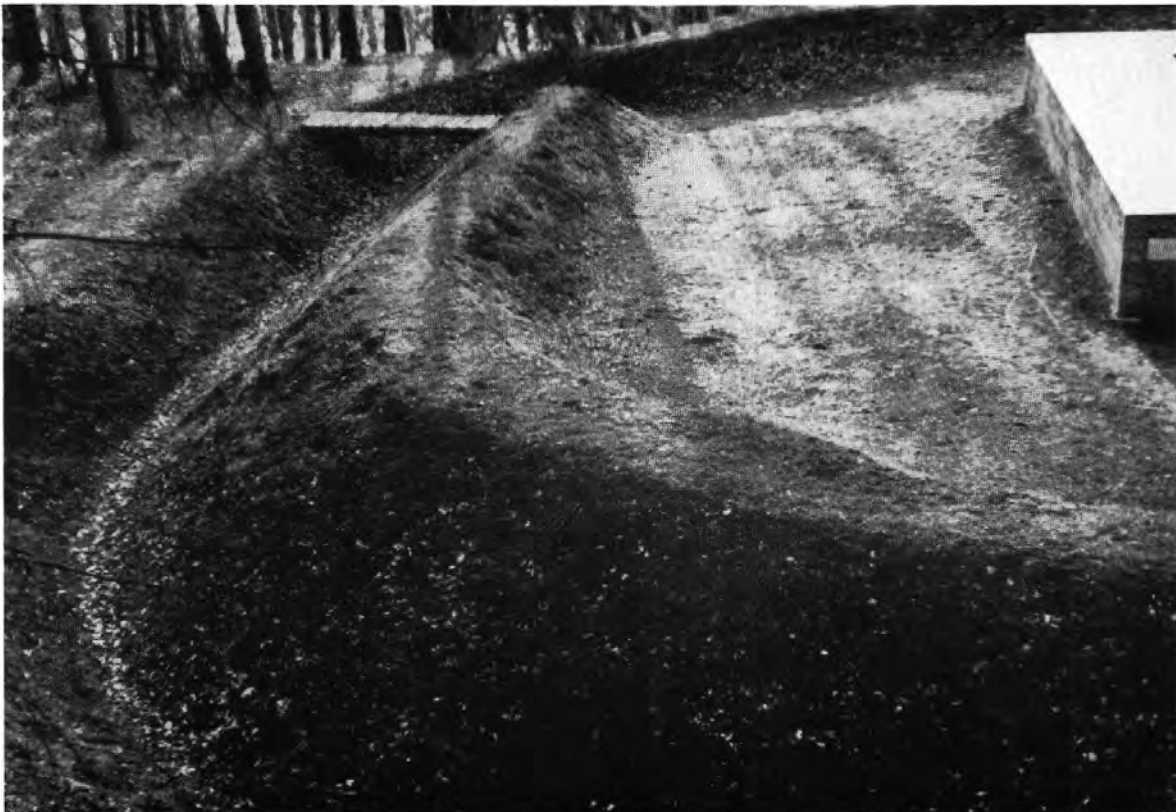
Taf. XXI, Abb. 2. Ellikon a. Rh. Römische Warte, Wall und Graben rekonstruiert (S. 122) Aus Ur-Schweiz, 1954 — Photo H. Isler
