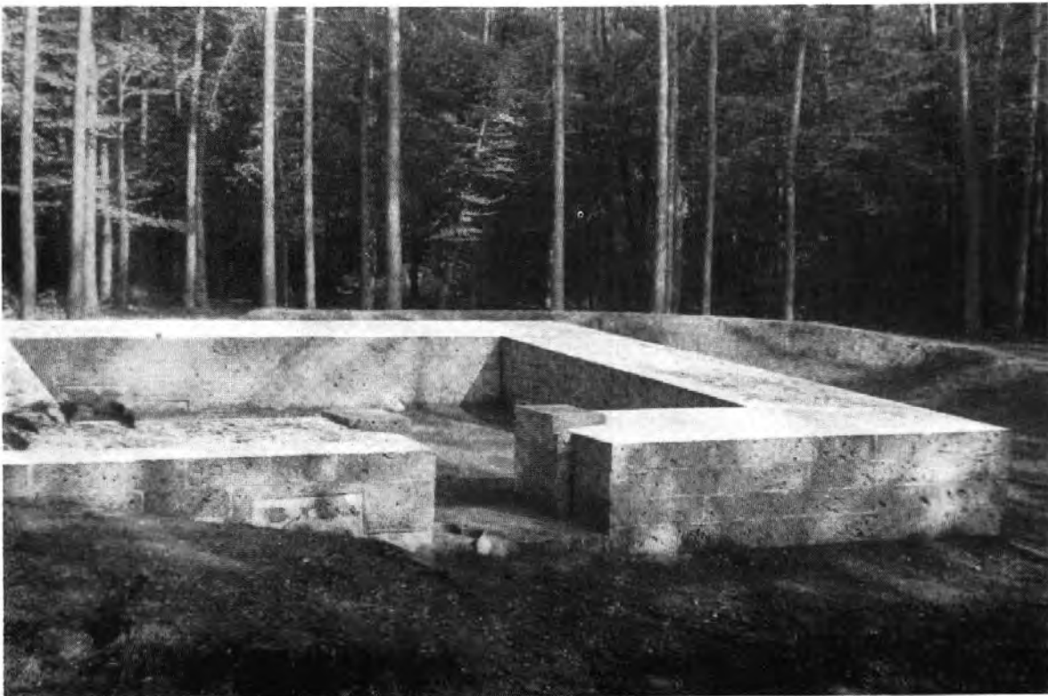
Taf. XXI, Abb. 1. Ellikon a. Rh. Römische Warte mit Tuffsteinverkleidung, fertig konserviert (S. 122) Aus Ur-Schweiz, 1954 — Photo O. Germann
