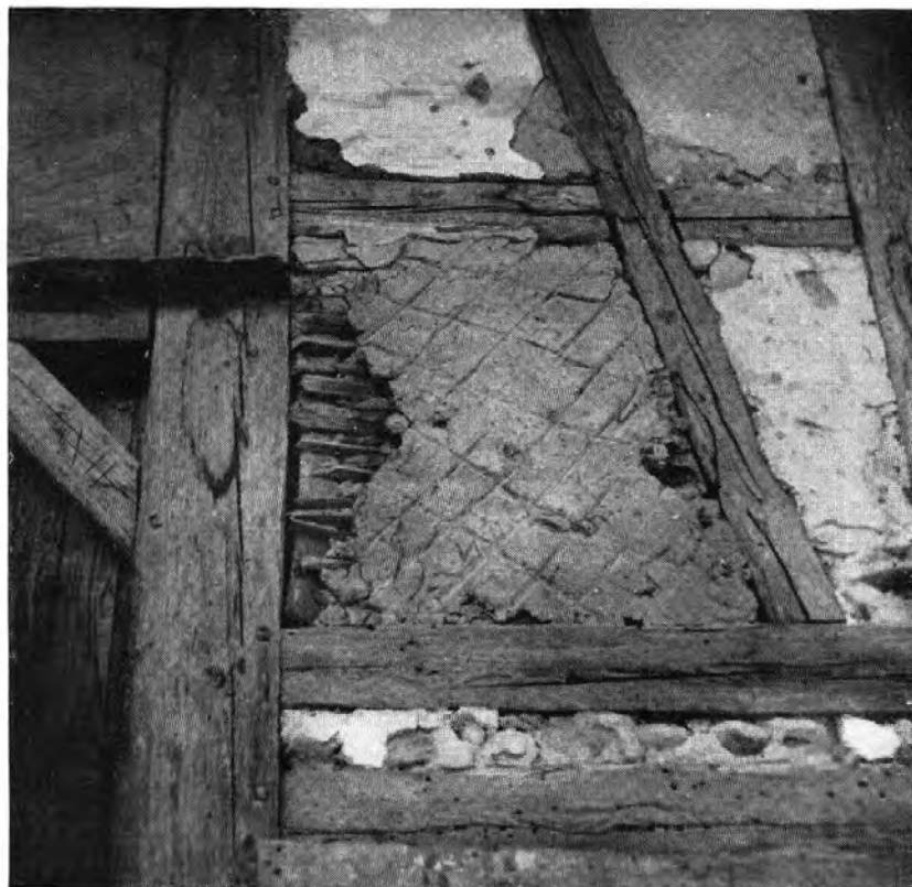
Taf. XI, Abb. 2. Endingen. Fachwerk an heute noch bestehendem Haus zu Vindonissa (S. 65)
