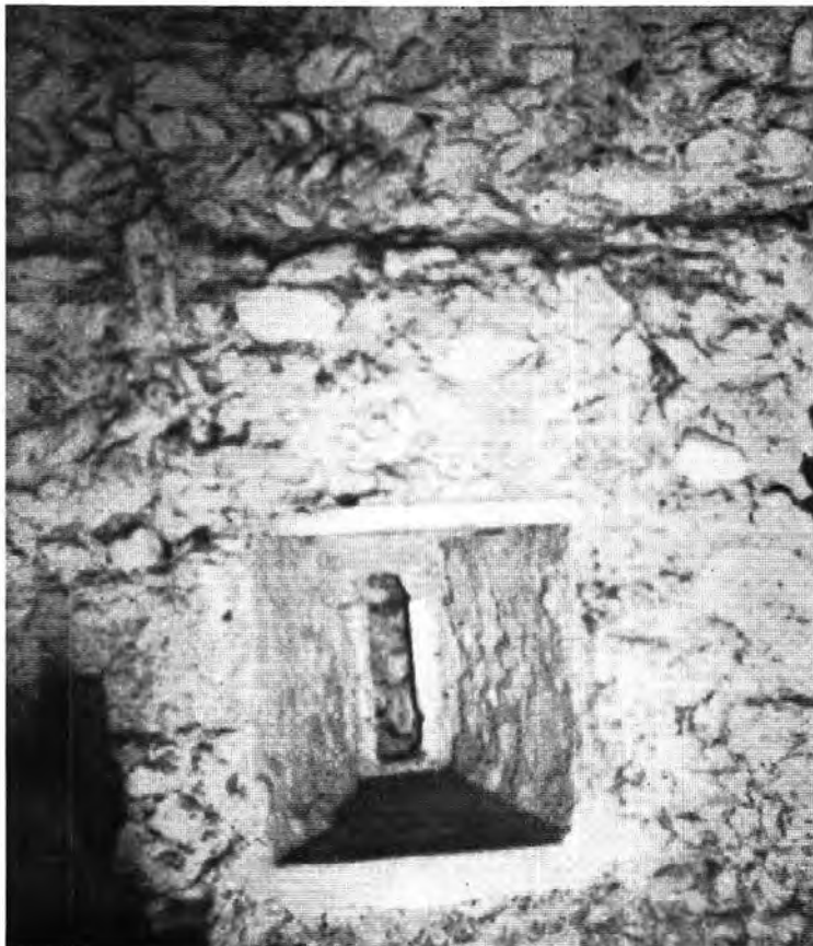
Tafel V, Abb. 2. Mörsburg. Fenster im römischen (?) Mauerwerk (S. 80)
