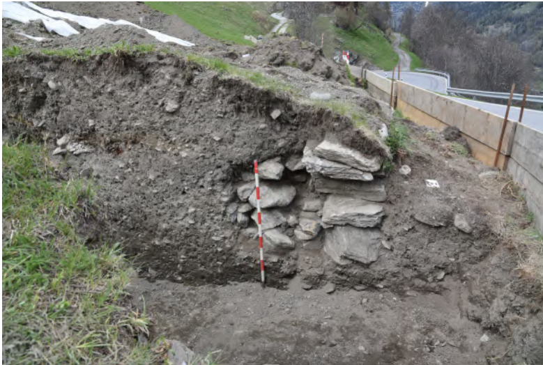
Fig. 33 – Grimentz, les Gères. Tranchée 1 (Tr. 1). Le mur M46, parementé du côté aval, monté contre terre sur sa face amont, pourrait avoir été construit lors de l'aménagement de la route actuelle au début du 20 e siècle, en tant que mur de soutènement. Vue du sud.
