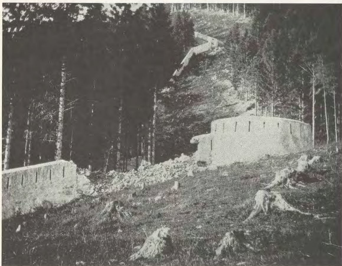
Fig. 38 Effet d'un tir de canon rayé sur un mur en maçonnerie, Sankt Luziensteig, 1864. Tiré de C.M.B. D'Apples: Rapport sur la pénétration des projectiles d'artillerie dans divers matériaux de construction des fortifications , ms., 1867. Archives fédérales, Berne.
