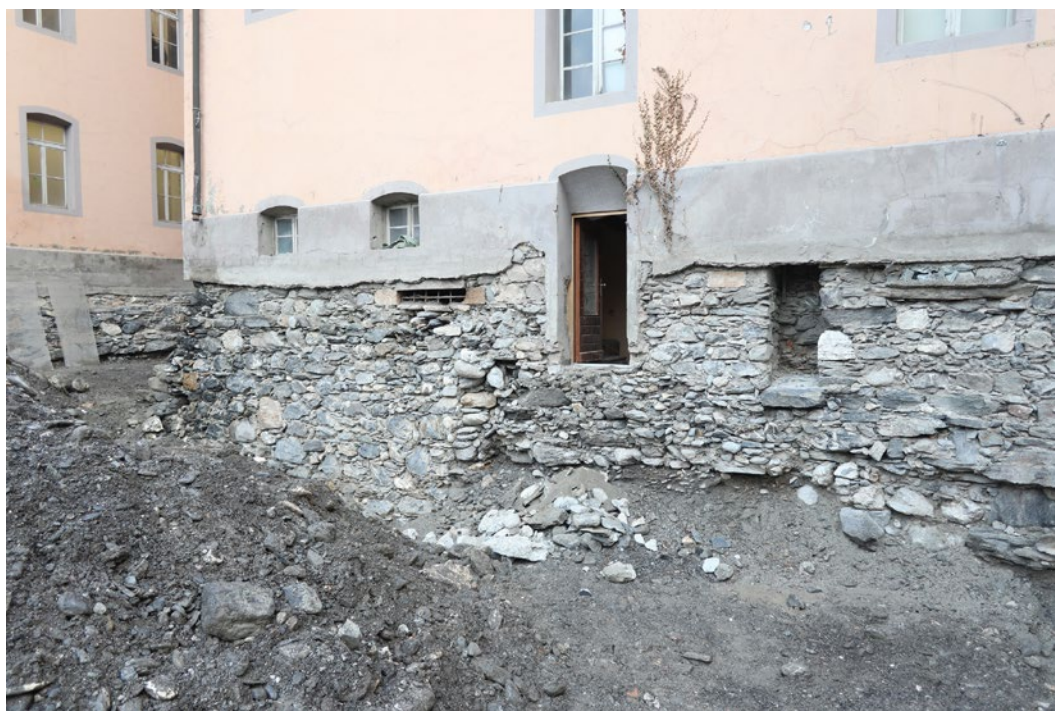
Fig. 16 – Sion, Ancien Hôpital. La maçonnerie des fondations est bien agencée et verticale comme montée en tranchées larges ou dans des excavations. Vue du sud. © InSitu SA-SIP.
