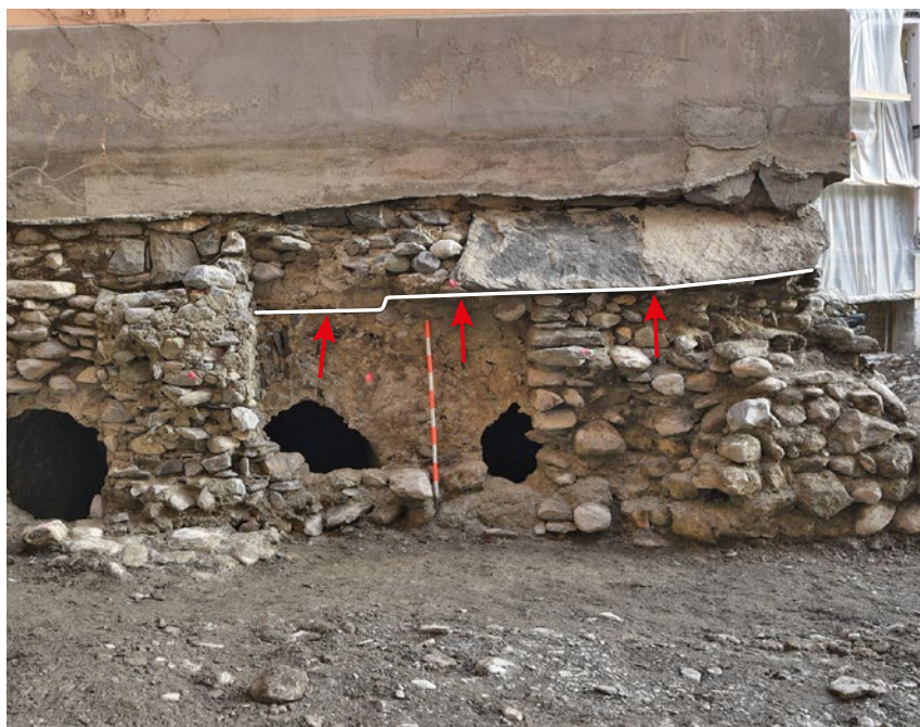
Fig. 23 – Sion, Ancien Hôpital. Les flèches désignent la limite entre le sommet de la maçonnerie du caveau et celle de la façade de l'avant-corps, fondée sur le caveau. © InSitu SA-SIP
