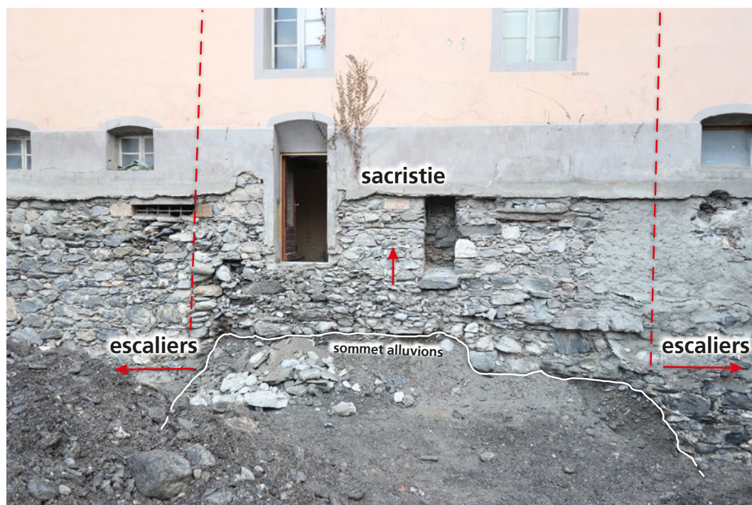
Fig. 17 – Sion, Ancien Hôpital. Les fondations de la façade sud-ouest de l'avant-corps sont plus profondes sous les escaliers que sous la sacristie située entre eux. Vue du sud-ouest. © InSitu SA-SIP.
