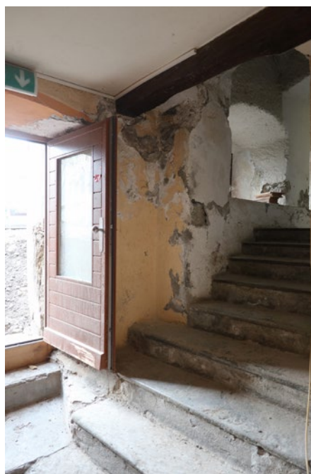
Fig. 22 – Sion, Ancien Hôpital. Le petit soubirail donne sur le caveau funéraire, sous l'escalier. Vue de l'est. © InSitu SA-SIP
