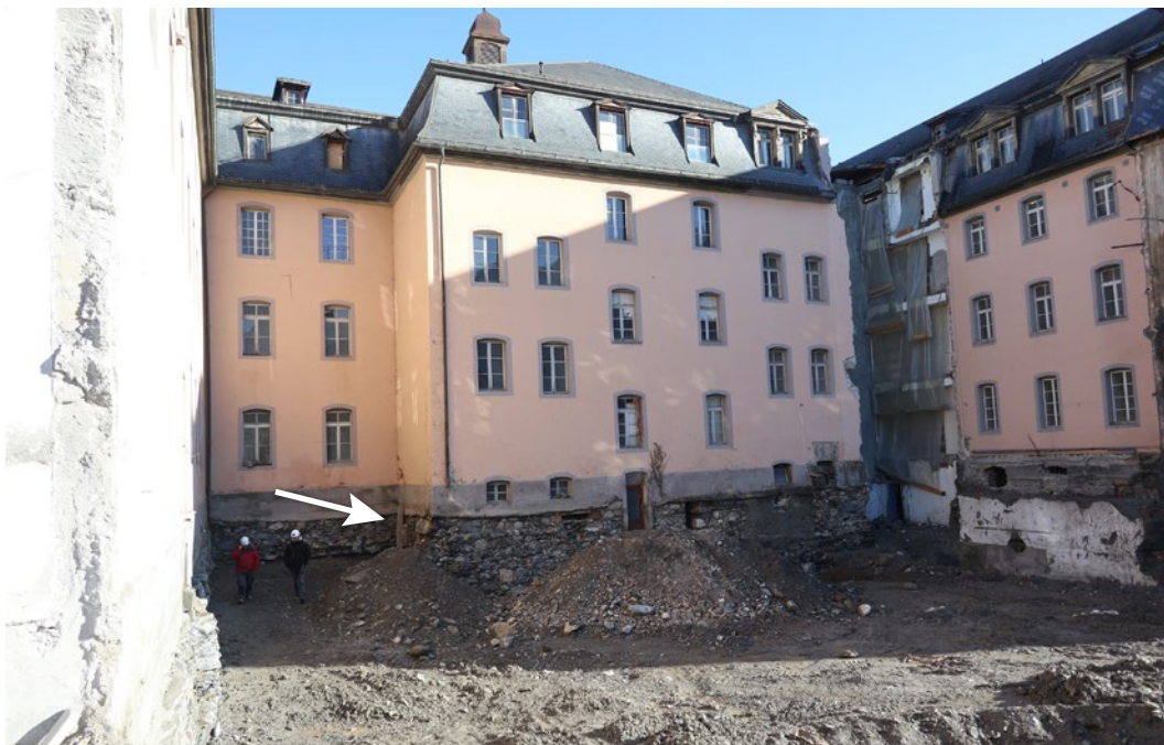
Fig. 4 – Sion, Ancien Hôpital. Vue générale du bâtiment du 18 e s. depuis la cour intérieure. Le secteur où se trouvent les tombes est désigné par une flèche. © InSitu-SIP.
