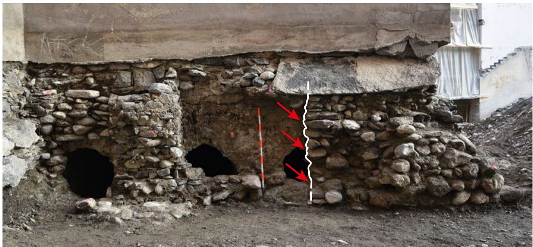
Fig. 12 – Sion, Ancien Hôpital. La maçonnerie arrachée est verticale et suggère la présence d'une porte (flèches). Vue du nord-ouest. © InSitu-SIP.
