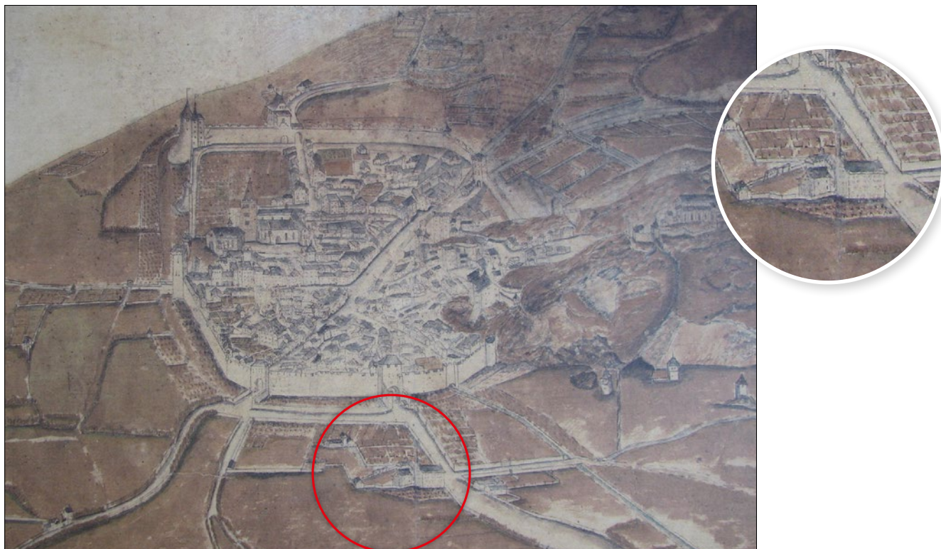
Fig. 3 – Sion, Ancien Hôpital. Vue de Sion en 1760, depuis le sud. Dans la loupe, un bâtiment massif pourrait refléter une des ailes du nouvel hôpital qui serait en cours de construction. Les sources informent que l'édifice aurait été construit en deux étapes.
