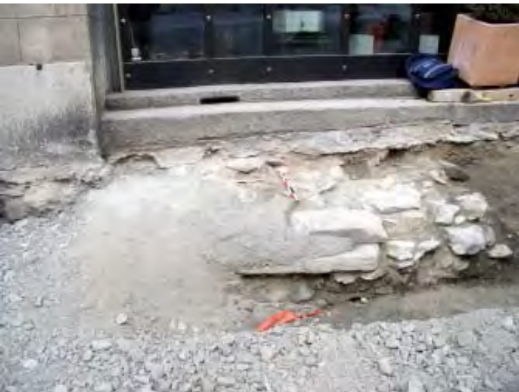
Fig. 34 Rue du Grand-Pont n° 9. Un ancien saut-de-loup de cave bouché. L'ouverture a été remplacée par une bouche d'aération dissimulée sous la vitrine, entre les deux marches en granit.
