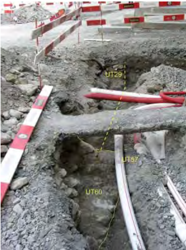
Fig. 31 Rue du Grand-Pont. Suite du mur UT29 au sud de la Grenette, vue depuis le sud.
