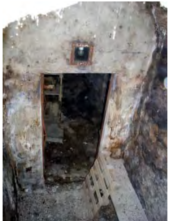
Fig. 35 Rue du Grand-Pont n° 9. La cave vue depuis le saut-de-loup. La cloison est probablement moderne.
