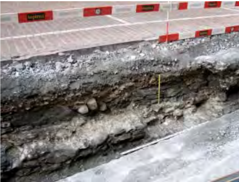
Fig. 24 Détail de l'image précédente. A gauche du double-mètre, le parement du mur de digue est percé peut-être pour l'aménagement d'un écoulement. Vue depuis l'est.
