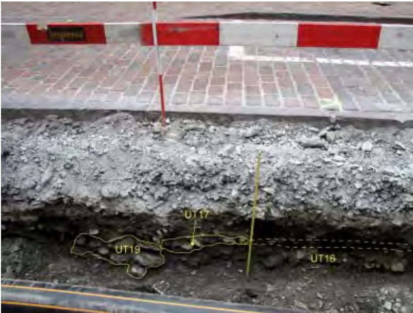
Fig. 39 Rue du Grand-Pont, profil occidental de la tranchée du sommet de la rue. La maçonnerie (UT19) est associée à un niveau de pavage en boulets de rivière (UT17) aménagé sur un remblai (UT16).
