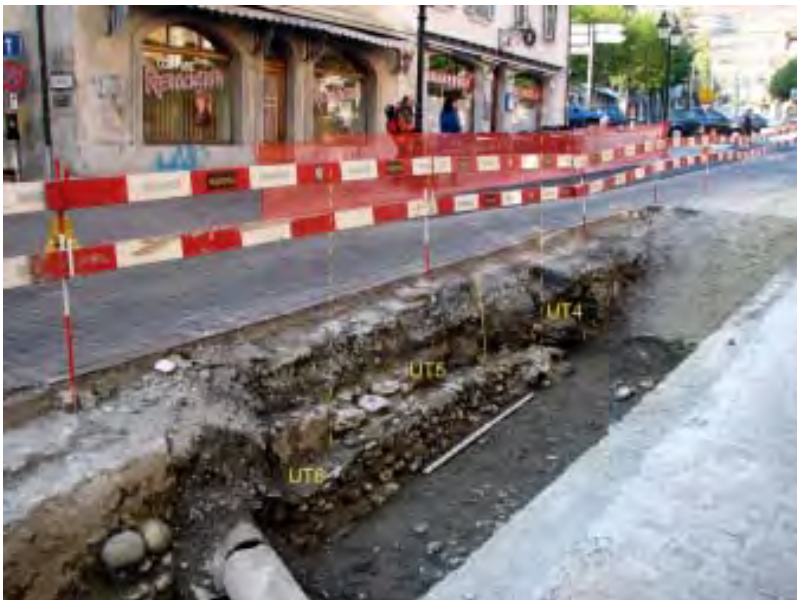
Fig. 25 Rue du Grand-Pont, dans l'axe de la ruelle des Pompes. Le mur de digue orientale vu depuis le sud-est. La maçonnerie (UT6) constitue le tablier du pont et le piédroit aval ; la maçonnerie plus récente (UT4) le piédroit amont. Une maçonnerie de mauvaise qualité (UT5) semble correspondre à une réfection et à un rehaussement du pont. A gauche de la canalisation, les restes d'un pavage en boulets de rivière.
