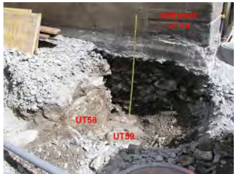
Fig. 18 Détail de la jonction entre le mur de digue et le bâtiment n° 14. Le mur de l'ancienne digue (UT58) et la maçonnerie qui lui est accolée (UT59) sont clairement percés par la fondation du bâtiment n° 14.
