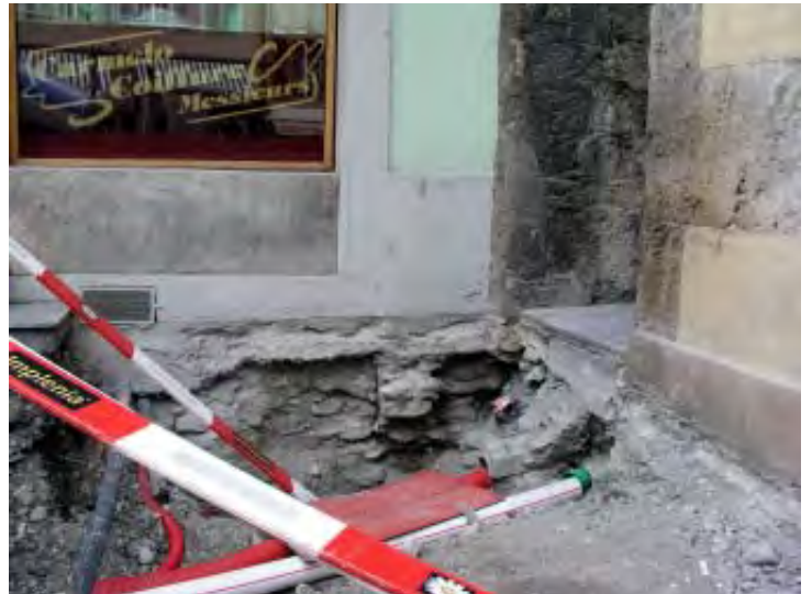
Fig. 12 Rue du Grand-Pont n° 16. Mur repéré devant le portail de la ruelle parallèle. Le parement nord de la maçonnerie UT53 sert d'appui à la fondation du bâtiment actuel.
