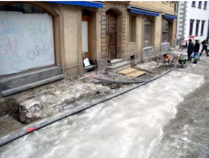
Fig. 40 Rue du Grand-Pont n° 14 (maison du Résident de France). Les deux regards de la Sionne depuis le nord. A gauche du 1 er regard, un seuil en grès (UT40) permet de situer la petite porte septentrionale qui figure sur le lavis de Antoine-Gabriel de Torrenté (fig. 9).
