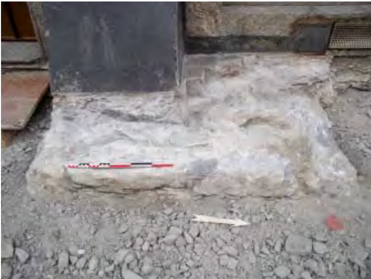
Fig. 36 Rue du Grand-Pont n° 9. Contrefort arasé, remplacé par une lésène plus étroite et moins saillante.
