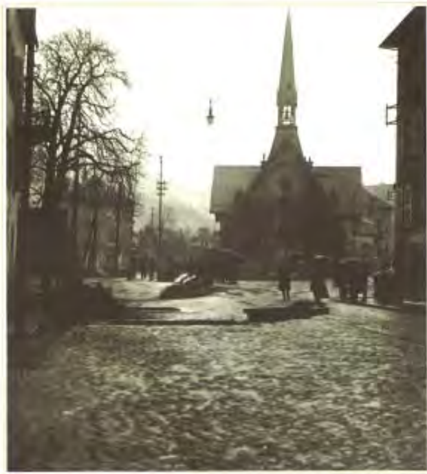
Fig. 42 Le sommet de la rue du Grand-Pont lors de l'inondation de janvier 1910. Les regards aménagés dans la voûte de la Sionne ont été ouverts, afin de libérer le lit de la rivière des branchages. Plus haut, à droite de la rue de Loèche, l'ancien temple protestant. CALPINI 1975, p. 192.
