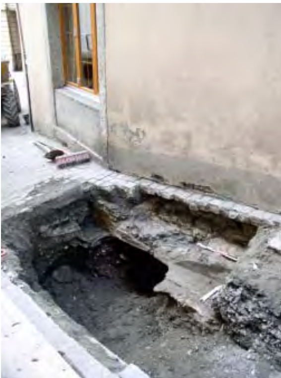
Fig. 44 Rue des Châteaux, vue depuis le sud-est. Le caniveau suivant les façades septentrionales de la rue a été dégagé sur une longueur de deux mètres.
