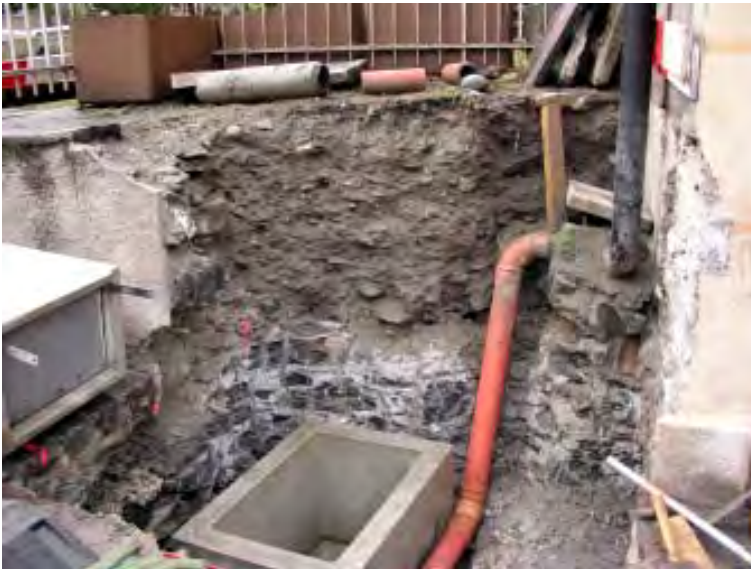
Fig. 45 Sommet du Grand-Pont, au nord de la maison n° 48, vue depuis l'ouest. Derrière le regard apparaît l'épaisse maçonnerie (UT23) correspondant à la fondation de la Porte de Loèche.
