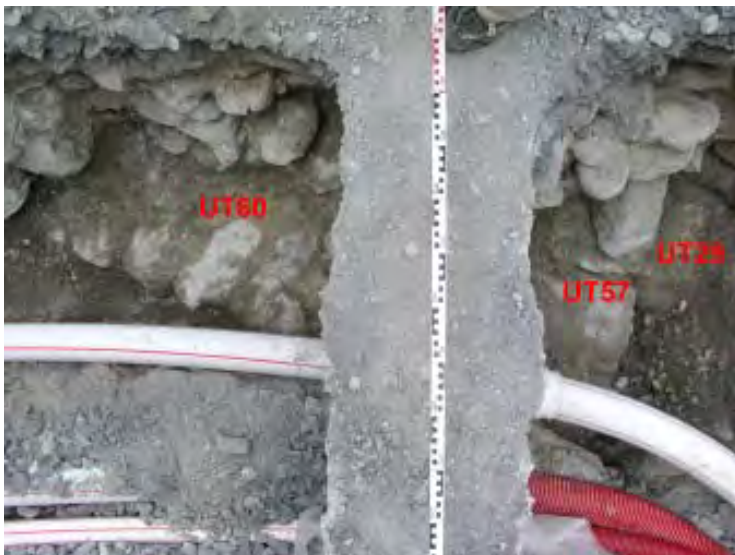
Fig. 15 Rue du Grand-Pont n os 18 et 20. Le chaînage d'angle formé par les maçonneries UT57 et 60 et la maçonnerie plus récente UT29. Vue depuis l'est.
