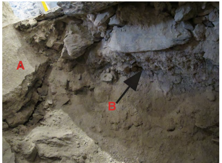
Fig 9 Sion, Majorie, Cage d'escalier. Sondage dans le sous-sol du rez-inférieur (vue du sud-ouest). A gauche, la colonne maçonnée dont la limite inférieure du crépi (A) coïncide avec le niveau d'herbe plus ancien indiqué par la flèche (B).
