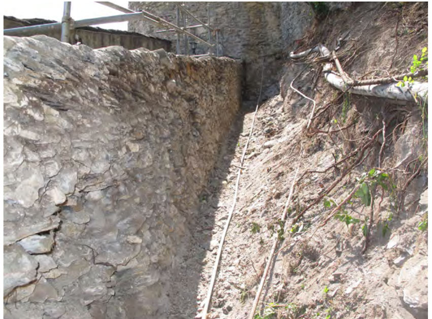
Fig 16 Sion, Majorie, galerie orientale. Extrémité ouest de la tranchée: la façade de la tour d'entrée est crépie sous le niveau des rem- blais. A gauche, le mur délimitant la rampe.
