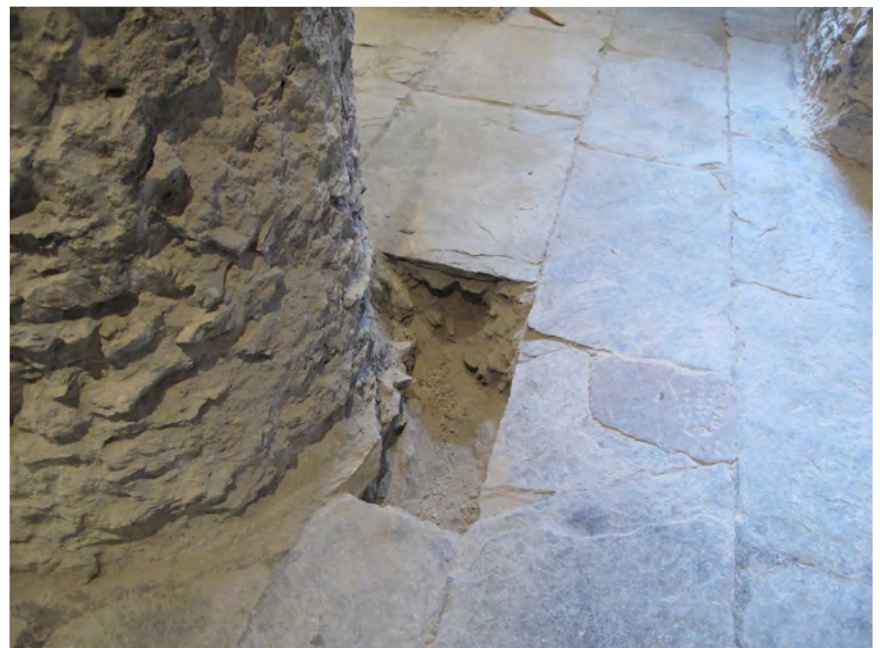
Fig 10 Sion, Majorie, Cage d'escalier. Sondage du rez-inférieur, vue de l'est. Du côté nord de la colonne, le rocher affleure 25 cm sous le dallage.
