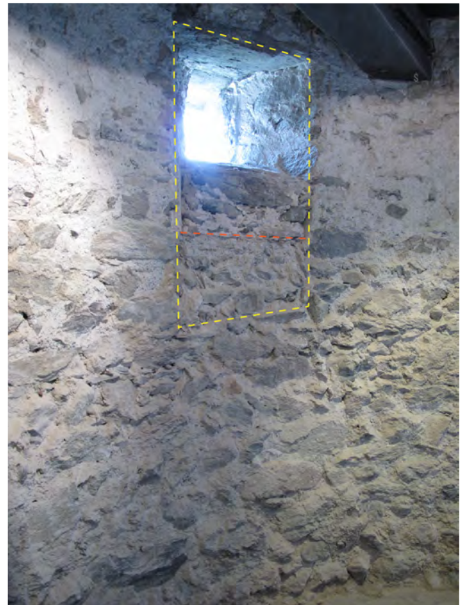
Fig 6 Sion, Majorie, Cage d'escalier. Fenêtre au rez-inférieur. D'origine dans la maçonnerie (en jaune), sa tablette a été exhaussée à deux reprises.
