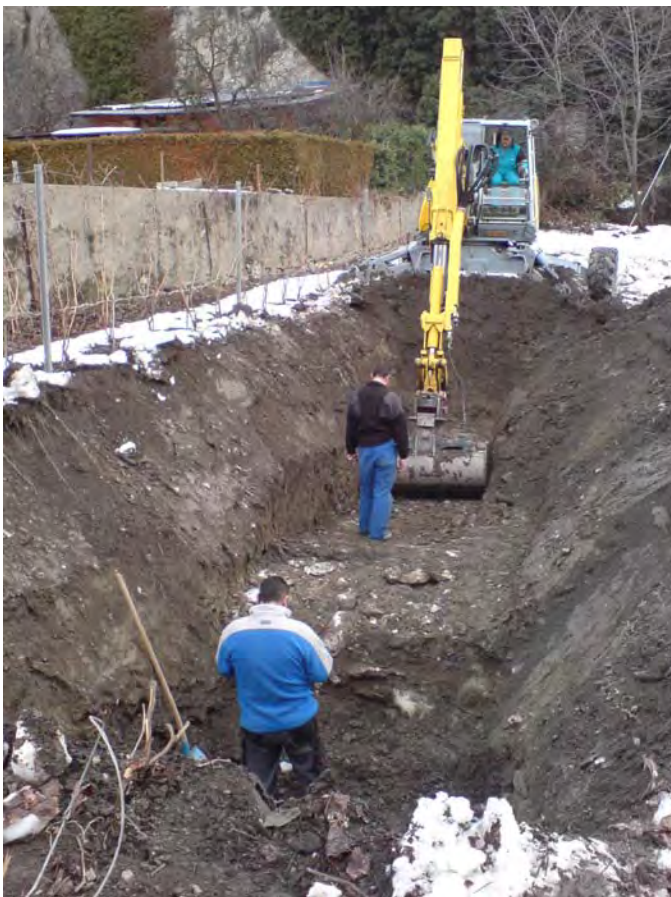
Fig. 3 – TU09 : Creusement du sondage 1.
