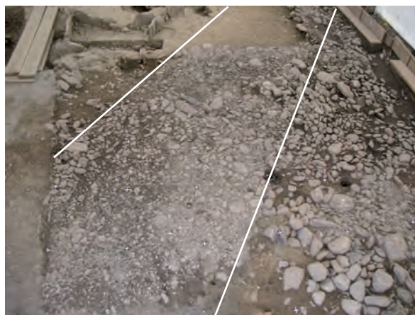
Figure 19 : Vue de la voie romaine en cours de dégagement.
