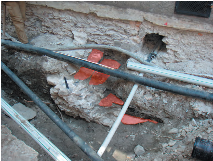
Fig. 24 Rue St-Théodule. Escalier (M80-82) donnant accès à une cave, vue depuis le sud. Sous la flèche, le limon latéral de l'escalier construit contre terre sur sa face extérieure ; en rouge, les marches et le palier inférieur de l'escalier.
