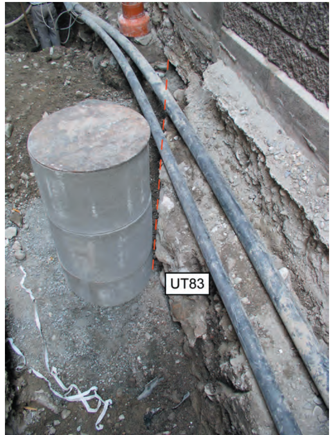
Fig. 23 Rue St-Théodule. A droite du regard d'égout, les vestiges d'un ancien mur (M83) dont le parement occidental diverge par rapport de la façade du bâtiment actuel.
