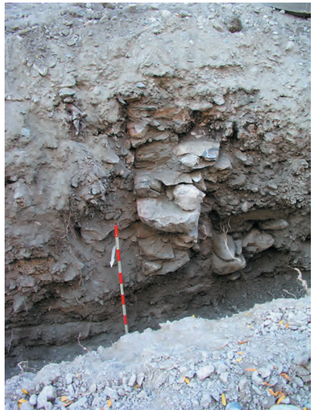
Fig. 16 Rue de Lausanne. Tranchée du collecteur au nord du Bagdad Café (n° 3), profil sud vu du nord. Mur de refend (M5) monté à droite, contre le remblai partiel de la cave occidentale du bâtiment 2.
