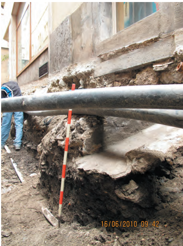
Fig. 29 Rue St-Théodule. Ancienne canalisation, embranchement latéral est (UT87) à forte inclinaison, vue du sud.
