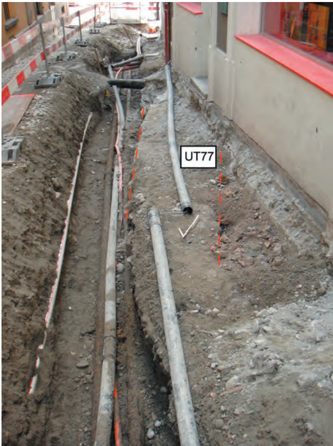
Fig. 22 Rue Supersaxo, vue depuis le nord. A droite de la tranchée, l'ancienne façade arasée (M77) dont les deux parements sont conservés sur une longueur de 2 mètres.
