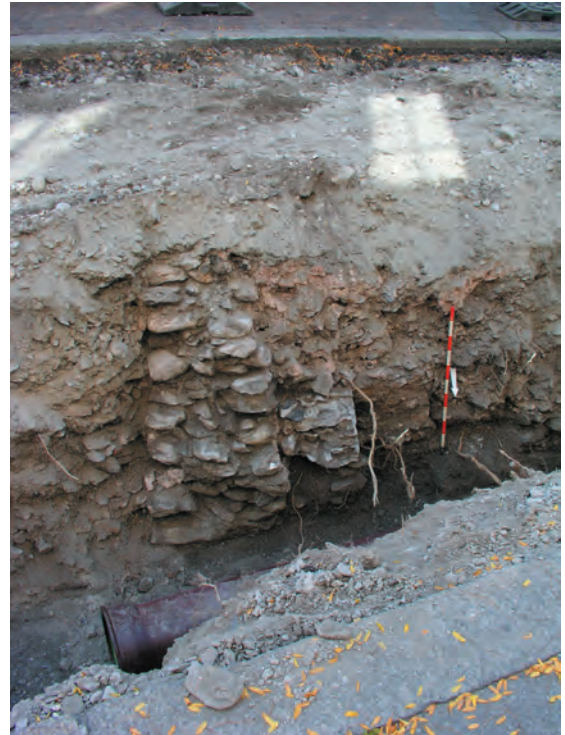
Fig. 14 Rue de Lausanne. Tranchée du collecteur au nord du Bagdad Café (n° 3), profil sud vu du nord. A gauche, le mur ouest (UT6) de la cave orientale du bâtiment 2 contre lequel un aménagement interne (UT7) est appuyé.
