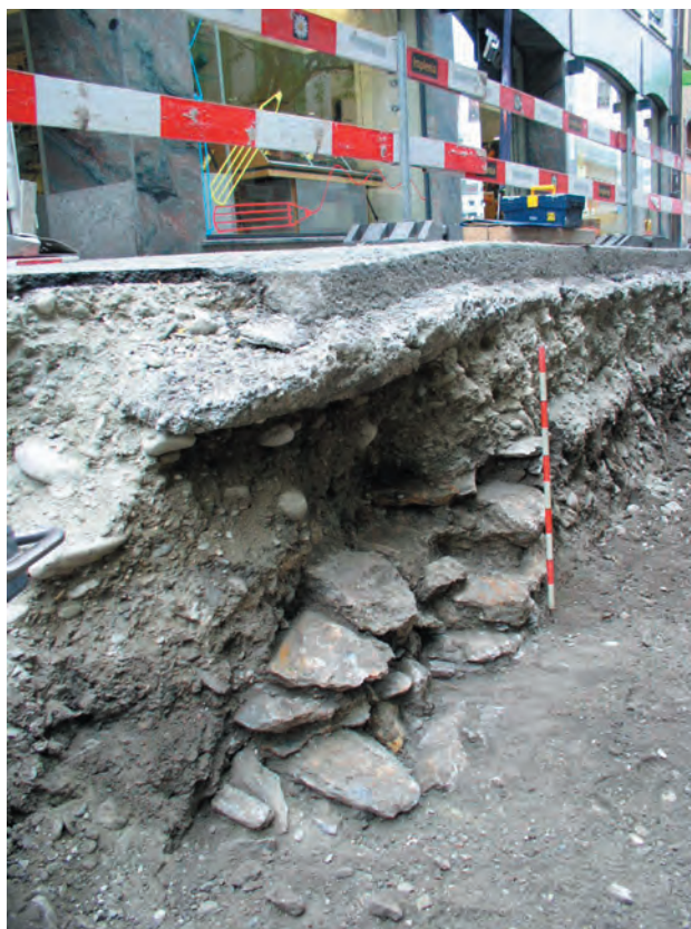
Fig. 21 Rue de Lausanne. Tranchée au nord de la pharmacie (no 15), profil sud vu de l'est. Fondation (M1) constituant jadis à l'enclos d'un jardin.
