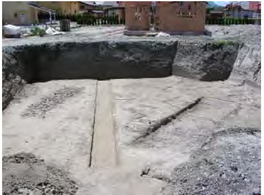
Fig. 4. Bramois / Chantier Chevrier. Vue générale des travaux effectués dans la parcelle n° 16350, depuis l'est. Au centre le sondage de contrôle effectué à la main ; à droite : le fond du sondage préliminaire ; à gauche : le fond du drain d'époque récente.
