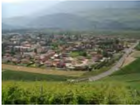
Fig. 2. Bramois / Chantier Chevrier. Vue générale du site depuis la route de Nax. Au centre de l'image, on distingue les deux excavations parmi les villas récemment construites.
