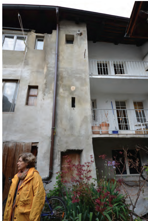
Fig. 2. Sion, rue de Savièse 26, façade orientale depuis la cour. La tourelle de latrines comporte un portillon de vidange qui remplace celui qui est visible dans la cave.
