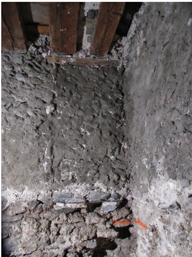
Fig. 8. Sion, rue de Savièse 26, cave après démontage de la voûte, paroi nord.
