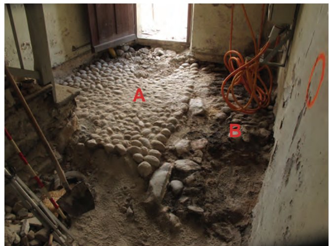
Fig. 6A et B. Sion, rue de Savièse 26, hall, vue vers le sud-ouest et vers le nord-est. Le pavement (A) était clairement délimité du côté nord par un empièchement de facture moins soignée (B), peut-être le soubassement d'un escalier en bois. L'escalier actuel perce le pavement constitué de boulets de rivière.
