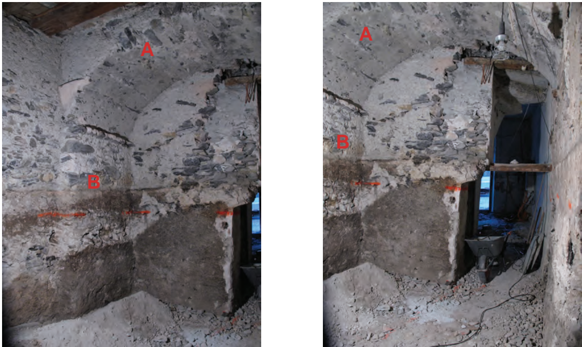
Fig. 5A et B. Sion, rue de Savièse 26, cave après démontage de la voûte, vue vers l'est. L'arc (A) est soutenu à gauche par un pilier (B) et ancré à droite (nord) dans la paroi. Le mur fermant le passage est clairement postérieur à l'arc, et les deux portes superposées sont percées dans ce mur.
