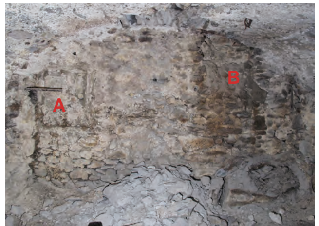
Fig. 1B. Sion, rue de Savièse 26, cave, paroi est. A gauche, le cadre du portillon de vidange de la tourelle de latrines (A). A droite le soupirail (B). La voûte est postérieure aux parois.
