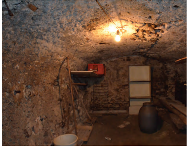
Fig. 1A. Sion, rue de Savièse 26, cave, vue est avant les travaux.
