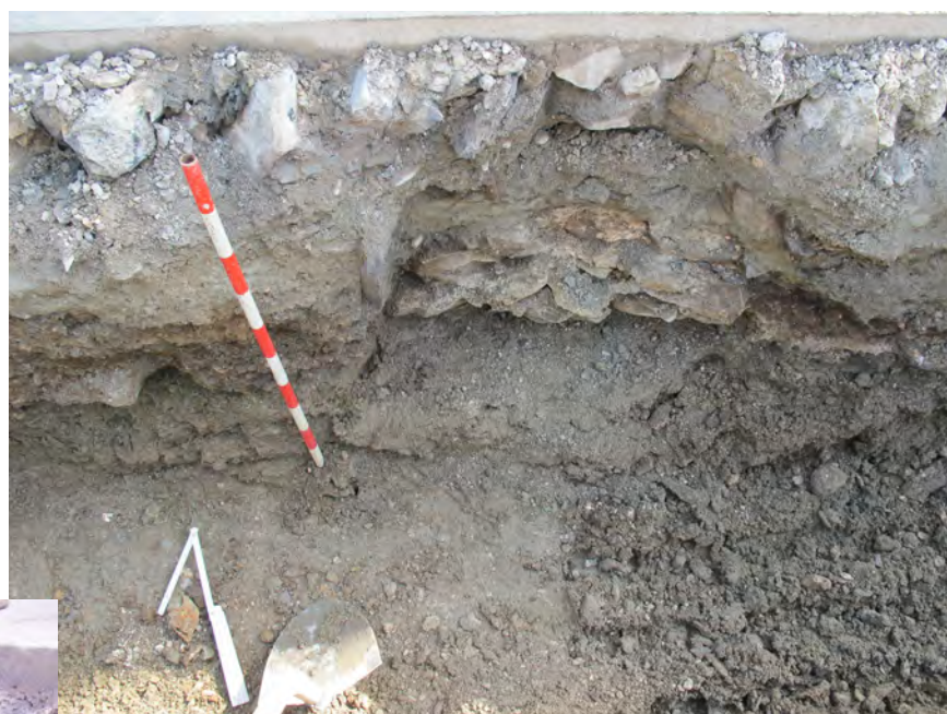
Fig. 26 Rue de Savièse ; tranchée à la hauteur de la maison n° 22 (profil est) : coupe à travers le mur M47. Le mur de refend M47 a été arasé avant la démolition du quartier. Le sol en relation avec ce mur devait se situer à la base de la pierre de chant qui double le parement nord du mur.
