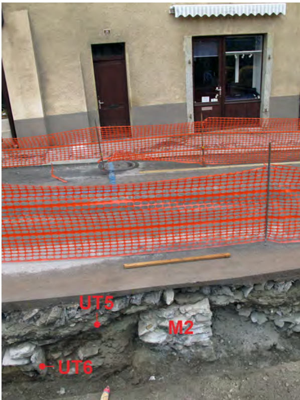
Fig. 15 Rue de Savièse ; tranchée à la hauteur de la maison n° 26 (profil est) : le mur mitoyen M2 séparant les Bâtiments 1 et 2. La rampe pavée (UT5) délimitée par la pierre posée de chant (UT6) indique l'emplacement de l'entrée à la cave semi-enterré du Bâtiment 1.
