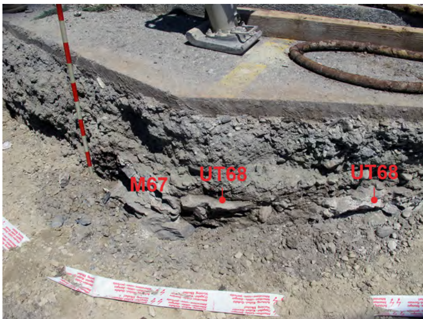
Fig. 29 Cour du home du Glarier ; tranchée à l'arrière du Bâtiment 4 (profil est) : mur M67. La maçonnerie aux parements arrachés (M67) et le sol constitué de petites dalles jointoyées au mortier (UT68) correspondent aux vestiges d'un petit édifice construit entre 1900 et 1918 (cf. plan de cadastre).
