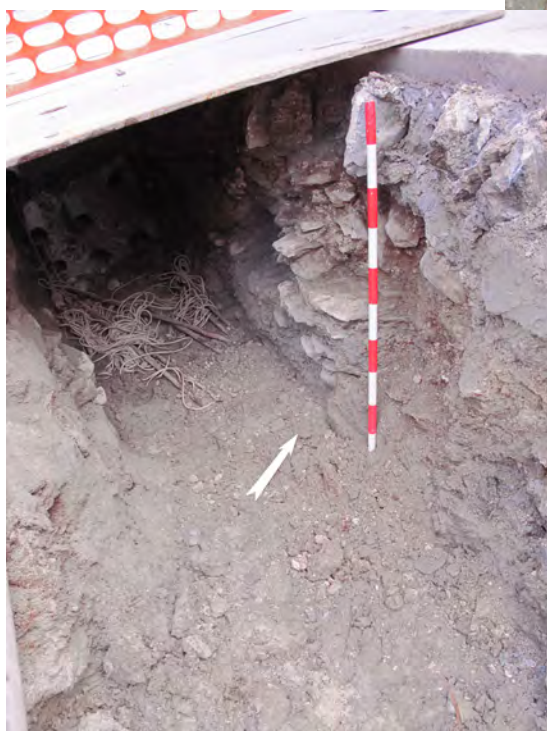
Fig. 27 Rue de Savièse ; tranchée à la hauteur de la maison n° 22 (profil est) : mur mitoyen M64 (à gauche du jalon) des Bâtiments 4 et 5.
