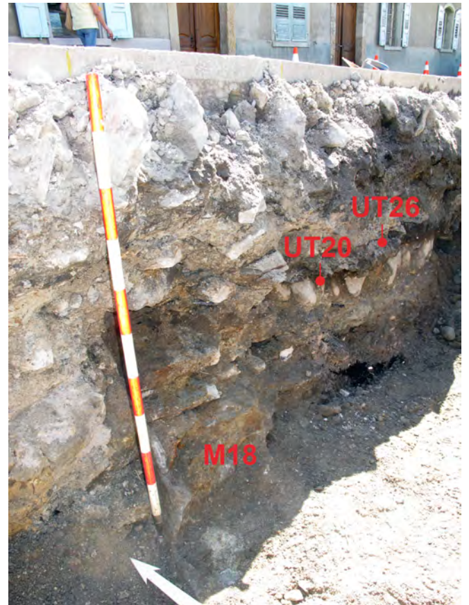
Fig. 17 Rue de Savièse ; tranchée à la hauteur de la maison n° 24 (profil est) : mur mitoyen (M18) des Bâtiments 2 et 3. Le crépi conservé contre la face nord du mur (côté jalon) indique que le sol du Bâtiment 2 se situe plus bas que le fond de la tranchée, tandis que le sol du Bâtiments 3, le pavement UT20 et le niveau de terre piétinée (UT26), se situe à mi-hauteur de la tranchée.
