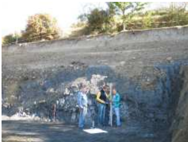
Fig. 11. Oberstalden, maison Furrer. Profil amont de l'excavation. Le socle rocheux, très irrégulier, est effrité en surface sur une épaisseur d'environ 1 mètre. Vue vers le nord-est.
