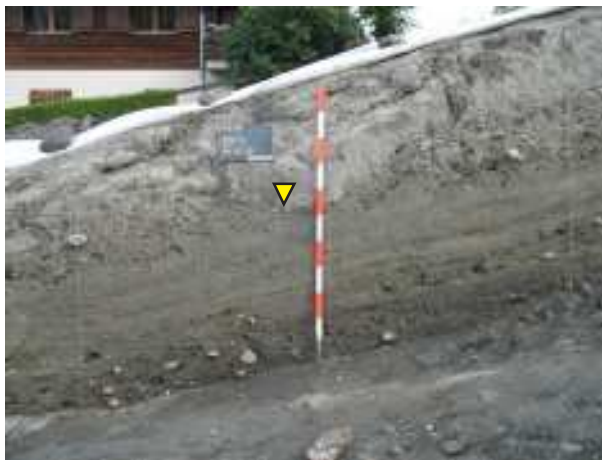
Fig. 16. Oberstalden, maison Furrer. Profil amont-aval (stg3), vue vers le nord-ouest. Détail de la séquence MA-MOD, constituée majoritairement de débordements de bisses. Le lit du bisse le plus récent est visible derrière la partie supérieure du jalon (flèche jaune).
