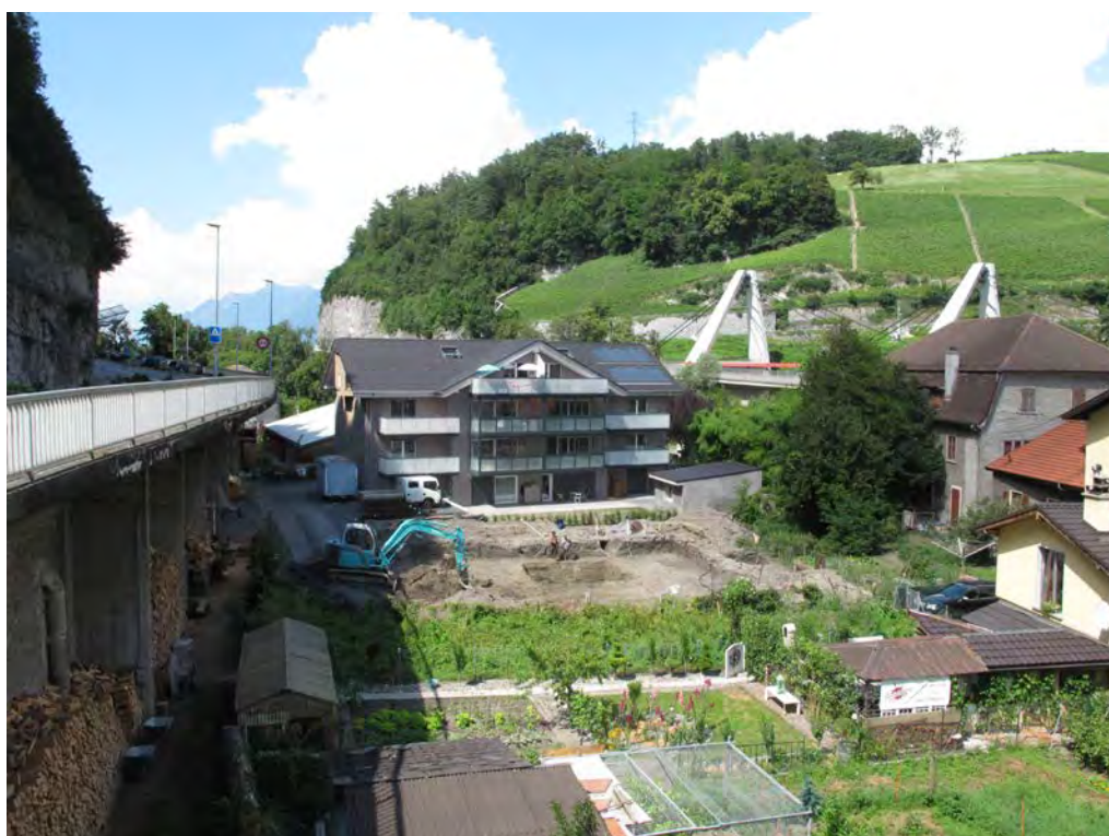
Fig. 2 St-Maurice, Glarier. Chantier au moment de la fouille de l'ascenseur. Vue depuis le sud.
