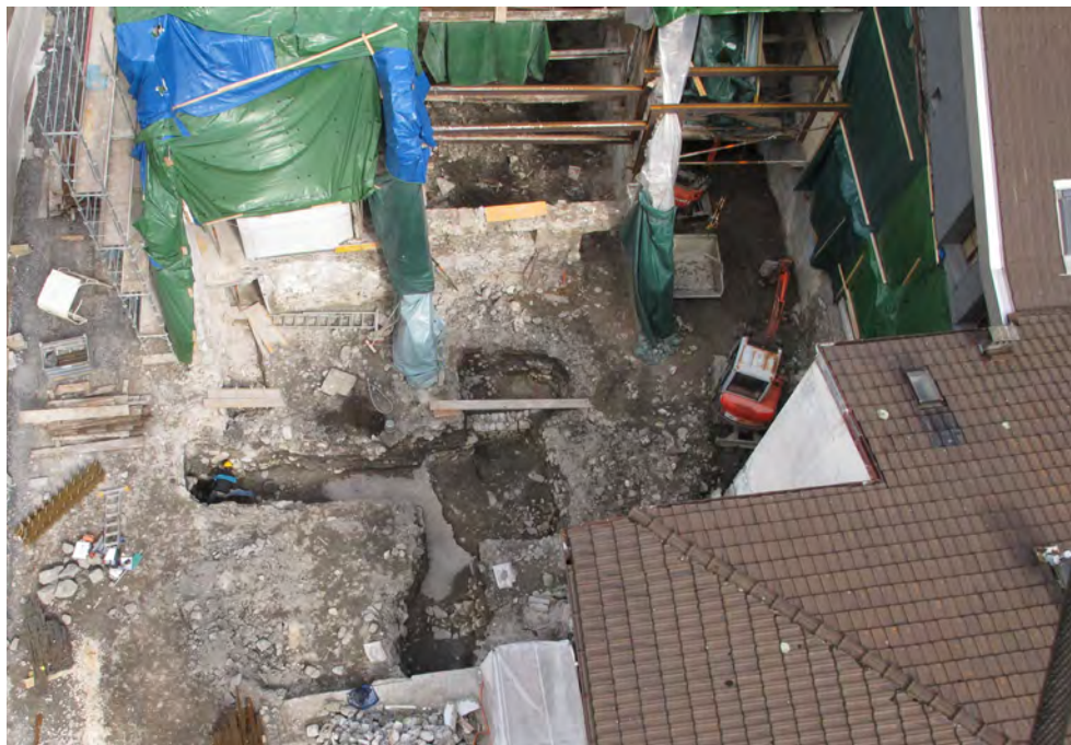
Vue du chantier depuis la grue, de l'ouest.
