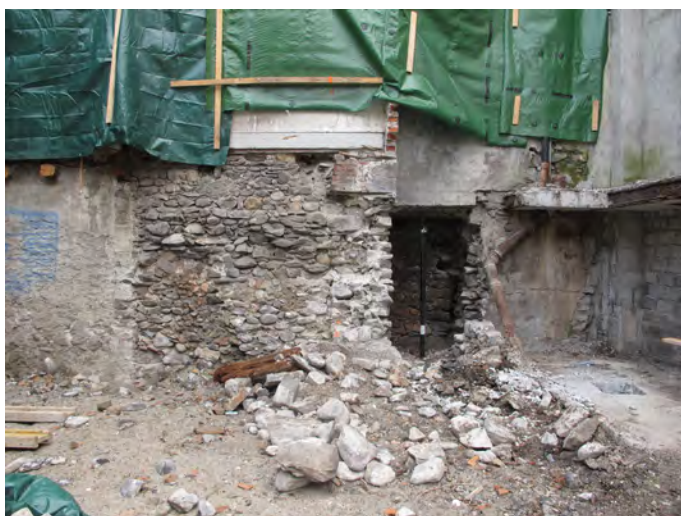
Fig. 17. St-Maurice, Maison Duc. Base de la façade nord du bâtiment n° 57 voisin de la maison Duc. Niche mise au jour après démolition d'une paroi de mauvaise facture. Vue depuis le nord.
