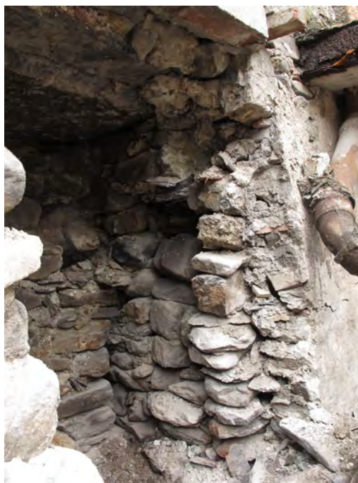
Fig. 18. St-Maurice, Maison Duc. Paroi nord de la niche, composée de plusieurs maçonneries incompréhensibles. Le plafond est constitué de deux grosses dalles. Vue du nord-est.
