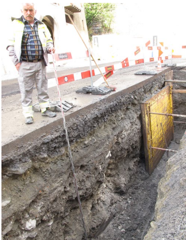
Fig. 18 – St-Maurice, Eglise du Parvis. Tranchée lors de l'installation de l'eau claire, à la hauteur du parvis. Au bout du jalon, à 3 m de profondeur, des restes de maçonnerie et de terre cuite trahissent la présence d'autres constructions sous les fondations du chœur de l'église. Vue du sud-est.
