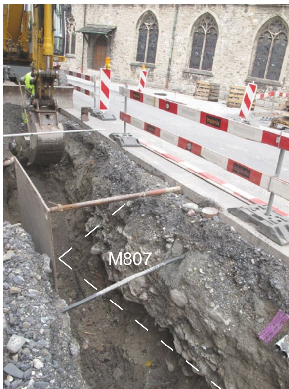
Fig. 42 – St-Maurice, Eglise du Parvis. Tranchée d'installation des eaux claires. Vue du nord-est. L'angle extérieur sud-est (M807) du local aménagé contre le chevet a été arraché par la machine et les travaux antérieurs, mais est restituable.
