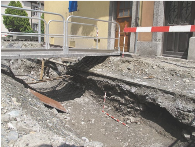
Fig. 109 – St-Maurice, Eglise du Parvis. Tranchée pour l'implantation de la conduite de gaz, à l'est de la maison Panisset. Vue du sud-ouest.
