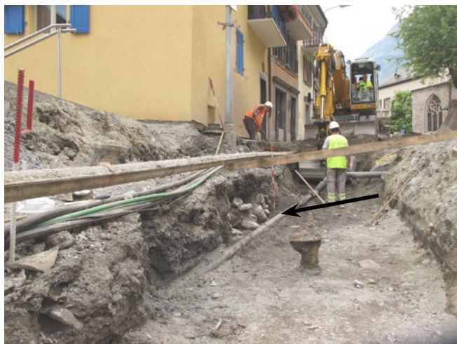
Fig. 107 – St-Maurice, Eglise du Parvis. Tranchée pour l'implantation de la conduite de gaz, à l'est de la maison Panisset. Vue du nord. La flèche désigne l'emplacement de la maçonnerie M11.
