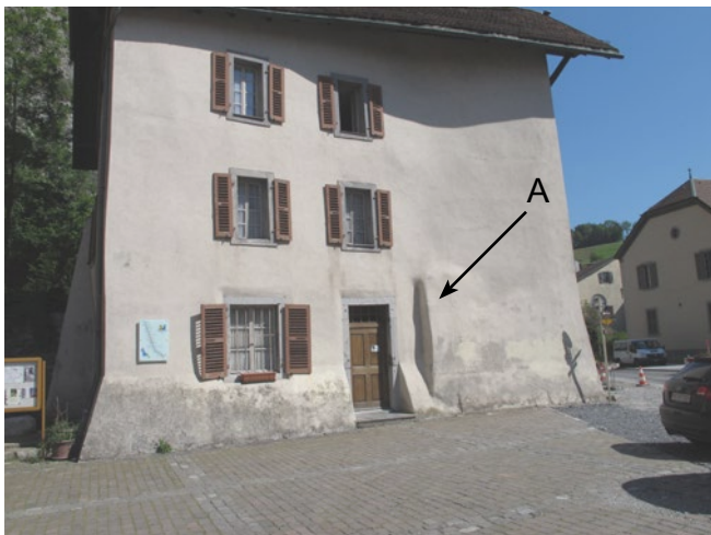
Fig. 73 – St-Maurice, Eglise du Parvis. Maison Panisset, façade sud. Vue du sud-ouest. A : décrochement dans la paroi qui pourrait être un reste de la paroi nord du parvis roman.
