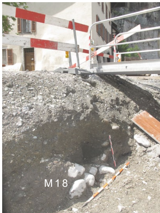
Fig. 111 – St-Maurice, Eglise du Parvis. Tranchée pour l'implantation de la conduite de gaz, à l'est de la maison Panisset. Vue du sud-est. La maçonnerie M18 ne peut pas être interprétée.
