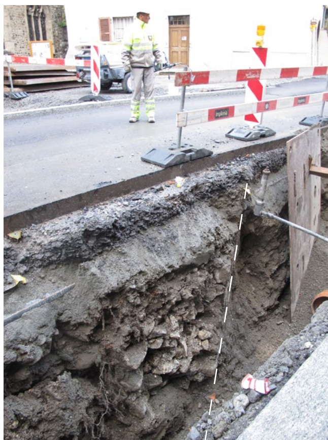
Fig. 25 – St-Maurice, Eglise du Parvis. Tranchée pour l'installation de l'eau claire. Vue du sud-est. La tranchée a arraché le parement extérieur (en traits-tirés blancs) de l'angle sud-est (M804) de l'annexe de l'église.
