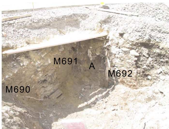
Fig. 99 – St-Maurice, Eglise du Parvis . Fosse pour silo à ordures. Vue du sud. Cave d'un bâtiment démoli dans les années 1960. M690 : partie primitive de la cave, avec le montant de la porte d'origine arquée. M691 : agrandissement nord. M692 : paroi nord de l'agrandissement, comprenant probablement la porte d'accès (A). Voir fig. 94 - 95, F.
