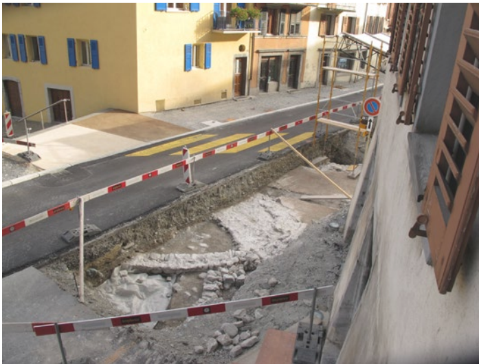
Fig. 13 – St-Maurice, Eglise du Parvis. Zone de fouille dégagée en 2012 dans le secteur du chœur de l'église. Vue du nord.
