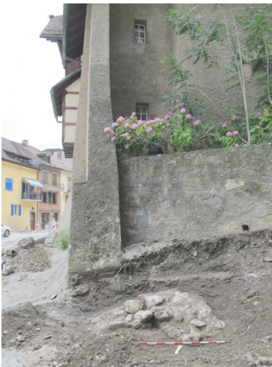
Fig. 104 – St-Maurice, Eglise du Parvis. Travaux au nord de la maison Panisset. Vue du nord. Localisation des murs M678 et M679.
