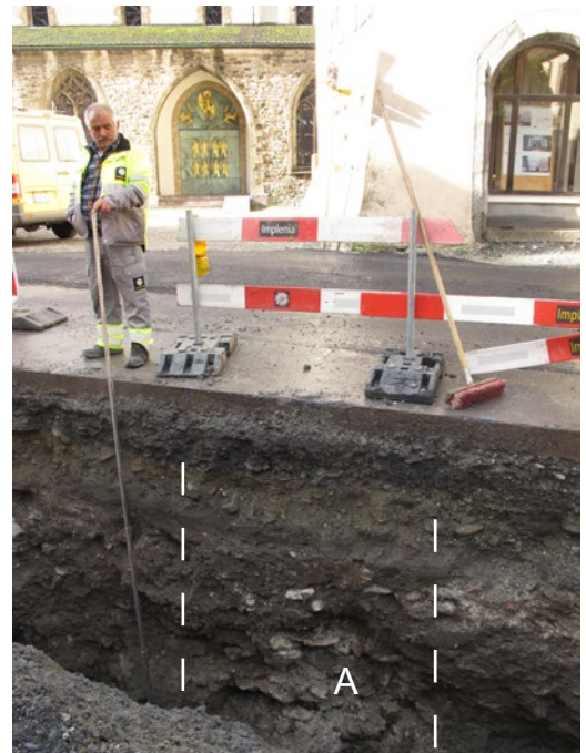
Fig. 40 – St-Maurice, Eglise du Parvis. Tranchée d'installation des eaux claires. / A : maçonnerie attribuable à un contrefort (M806) chaîné au pan central du chevet. Vue depuis le sud-est.
