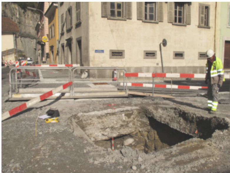
Fig. 52. St-Maurice, avenue d'Agaune. Bâtiment D, intervention d'urgence (étape 18). Secteur au sud de l'aula. Situation des vestiges. Vue depuis le sud.
