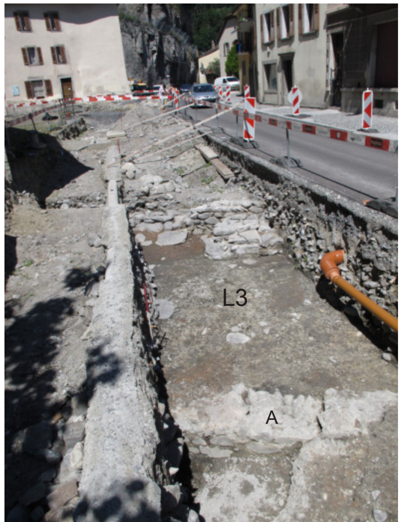
Fig. 10. St-Maurice, avenue d'Agaune. Dégagement des derniers niveaux du bâtiment D, en 2013. Ici le local L3. A: mur le plus ancien mis au jour dans ce bâtiment. Il prédétermine l'axe des locaux de celui-ci.
