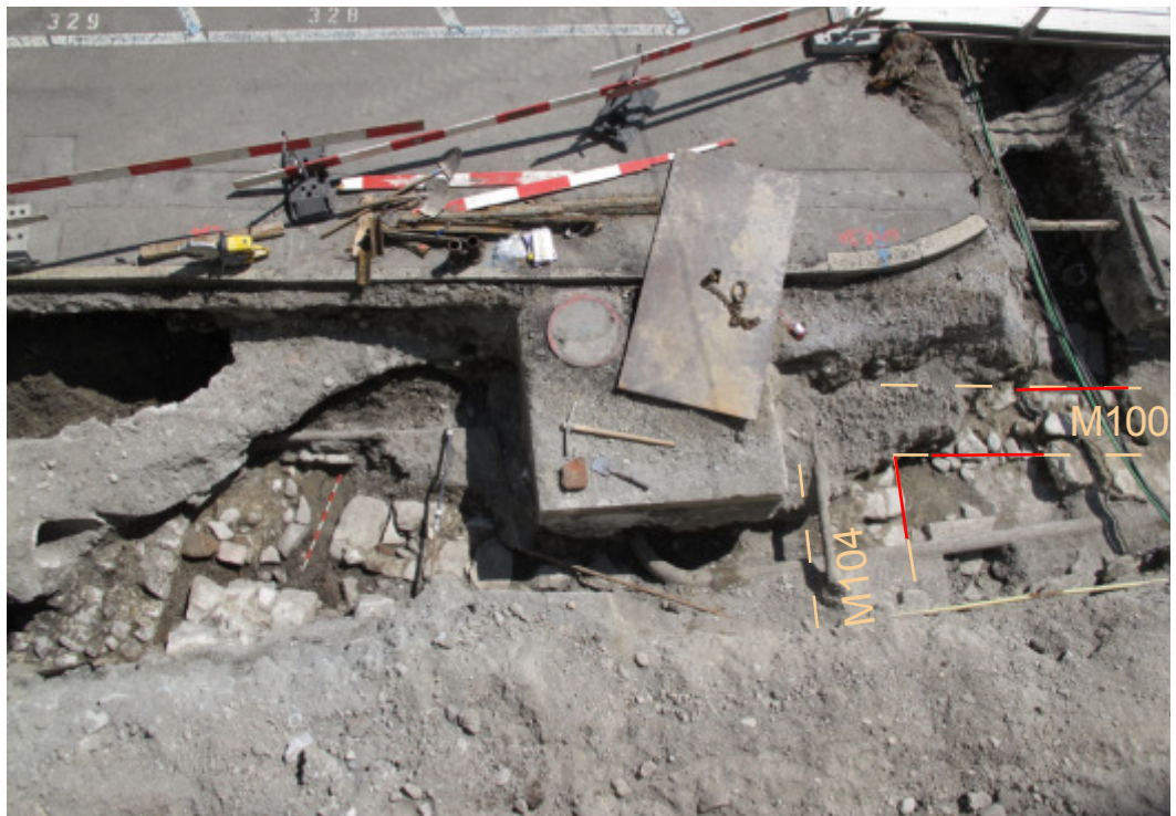
Fig. 12. St-Maurice, avenue d'Agaune. Bâtiment D, angle sud-est, lors de l'intervention de 2012 (étape 5). M100 et M104 : murs sud et est du local L1 lors de la phase 1. En rouge: les parements observés. En jaune: les restitutions. Vue depuis le nord, vers le bas.
