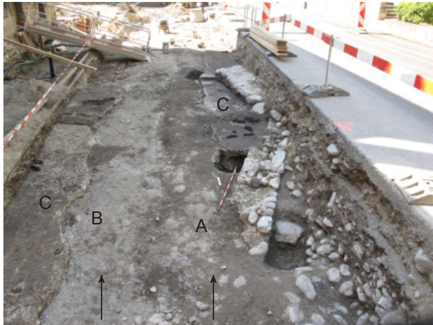
Fig. 9. St-Maurice, avenue d'Agaune. Travaux de 2012 (étape 7). Les deux flèches indiquent les deux excavations anciennes, pour le collecteur en 1911 (A) et pour la conduite de fin 1960 - début 1970 (B). Toutes deux ont entamé le sol de l' aula (C). Elles se distinguent par la différence de séchage de leur comblement. Vue depuis le nord.
