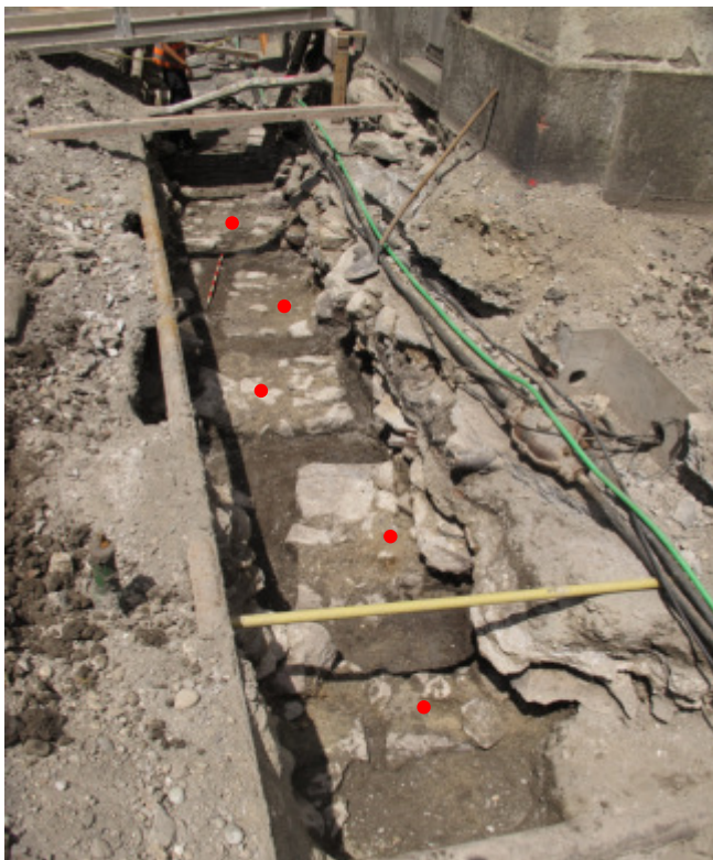
Fig. 18. St-Maurice, avenue d'Agaune. Bâtiment D, intervention d'urgence (étape 3). Les points rouges désignent les socles UT45 (ici arasés) portant le sol de la phase 3. Vue depuis le sud.
