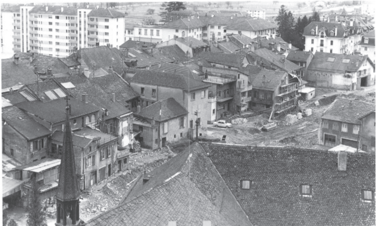
Fig. 6. St-Maurice, avenue d'Agaune. Vue du chantier de percement de l'avenue d'Agaune dans les années 1960. Vue depuis le clocher de la basilique. (Tiré de R. Berguerand, St-Maurice - hier et avant-hier , bulletin de l'Association St-Maurice d'Agaune, 2003).
