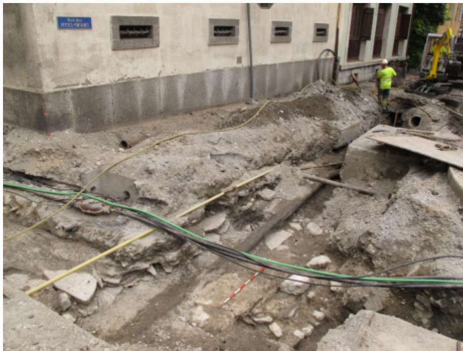
Fig. 4. St-Maurice, avenue d'Agaune. Conditions d'une intervention d'urgence (étape 4).
