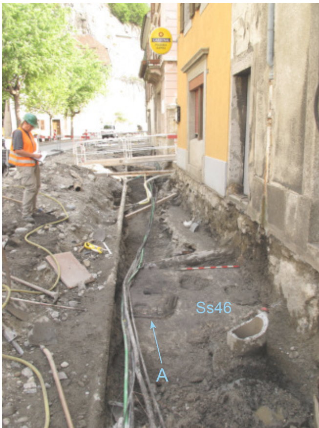
Fig. 21. St-Maurice, avenue d'Agaune. Bâtiment D, intervention d'urgence (étape 3). A: sommet de la base de pilier en marbre UT69 émergeant à peine du dernier sol Ss46 de l'aula. Ici, lors de sa découverte. Vue depuis le sud.
