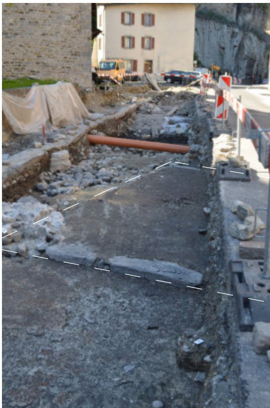
Fig. 25. St-Maurice, avenue d'Agaune. Bâtiment D lors de son dégagement (étape 22). Les traits-tirés délimitent le podium. Les bordures sont des pierres taillées alignées. Vue depuis le sud.
