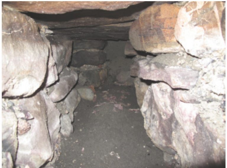
Fig. 20. St-Maurice, avenue d'Agaune. Bâtiment D, intervention d'urgence (étape 3). Détail des canaux entre les socles du dernier sol de l'aula. Dans ce secteur nord, les canaux ne sont pas comblés de sédiments. Vue depuis l'ouest.
