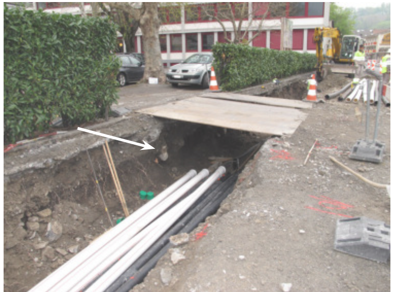
Fig. 95. St-Maurice, avenue d'Agaune. Situation de l'étape d'intervention 23. Vue depuis le sud-est. Situation sur fig. 94
