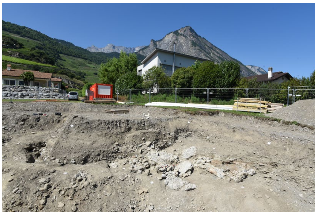
Fig. 8 – Saillon, maison Thurre. Les tronçons de murs amoncelés en aval du chantier de 2023. Vue du sud.
