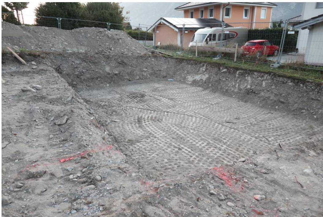
Fig. 2 – Saillon, maison Hugo. Vue générale de l'excavation pour la piscine, depuis le nord-ouest.
