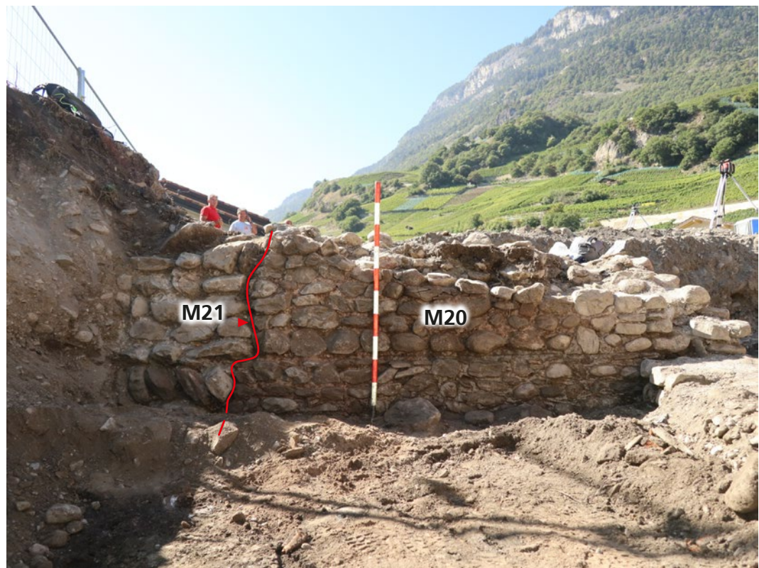
Fig. 23 – Saillon, maison Hugo. Le mur M21 répare le mur M20. Son ressaut de fondation correspond à la planie d'assise du premier. Vue de l'est.
