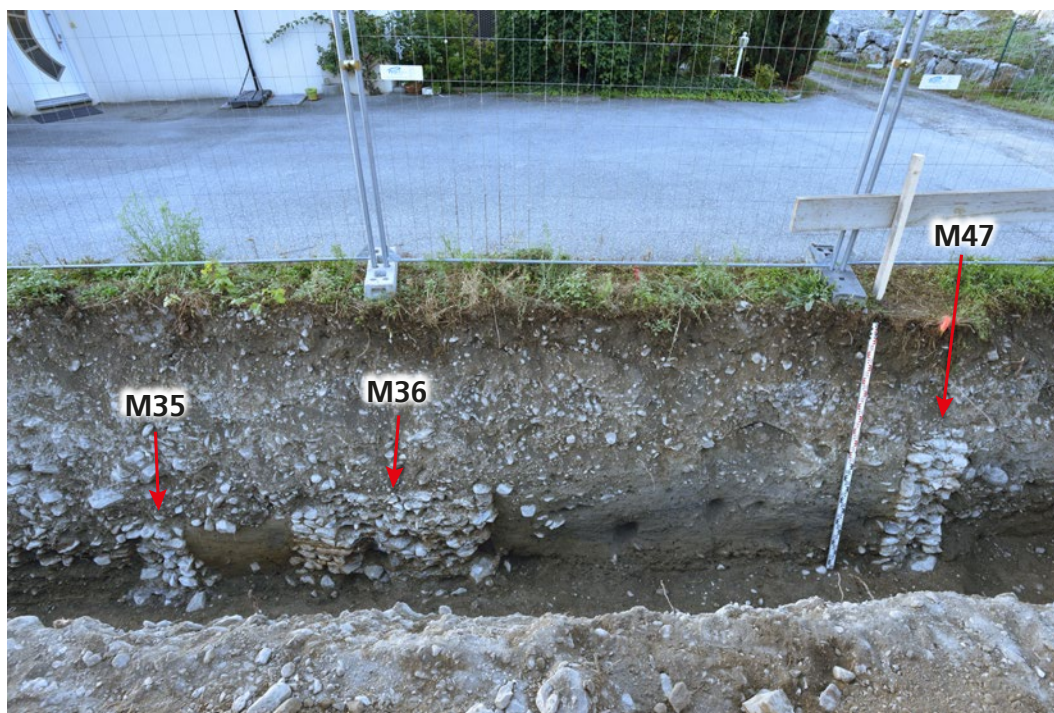
Fig. 18 – Saillon, maison Hugo. Les murs M35, M36, M47 délimitent les locaux L. 2.3, 2.4, 2.5. Vue du nord.
