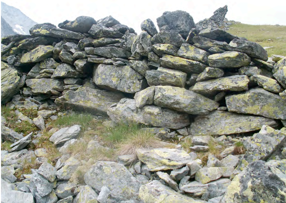
Figure 21, Mur d'Hannibal, reste du parement dans le second segment longitudinal
