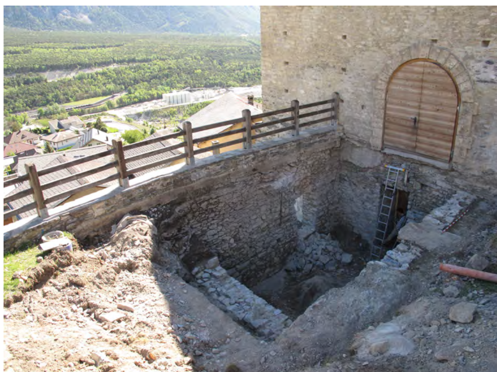
Vue des travaux, depuis le nord-est
