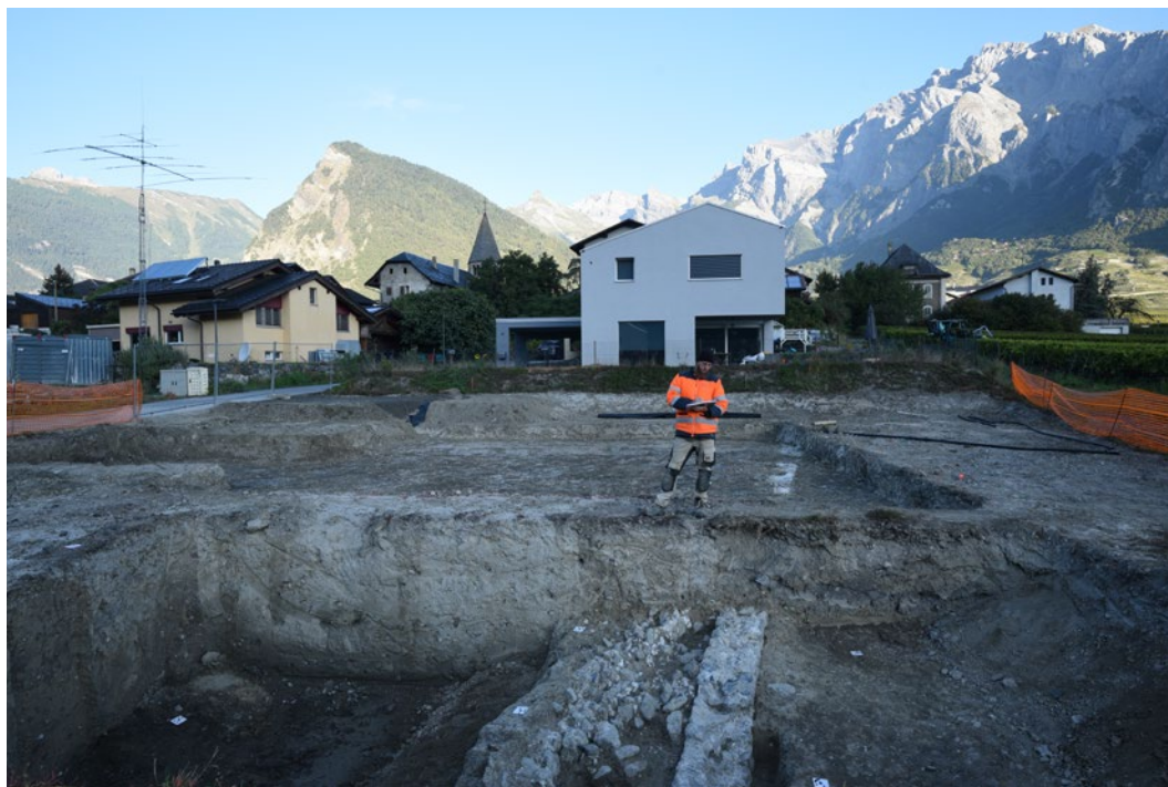
Fig.11 – St-Pierre-de-Clages. Le mur M21 au premier plan. Il se poursuit en direction du nord-ouest (visible à l'arrière-plan). Vue en direction du nord-ouest.
