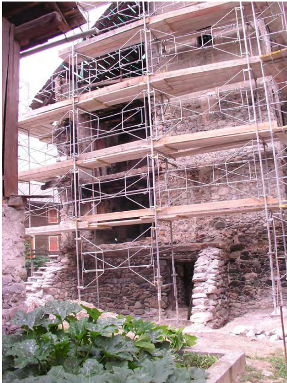
Fig. 1 Façade Sud. Le corps Sud était en grande partie démolli à notre arrivée. Du socle subsistent le mur nord (1) avec l'entrée (5) et les amorces des murs Est et Ouest.
