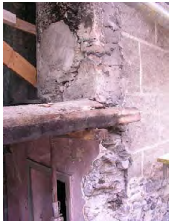
Fig. 7 Façade Sud, état après arrachement du Corps Sud. La poutre horizontale indique l'emplacement du sol au niveau des combles. Au-dessous : le mur arraché (48) contre lequel vient buter la réfection de la cage d'escalier. Au-dessus : l'angle de la cage d'escalier (2B) contre lequel devait s'appuyer le mur (49) plus récent (négatif respecté par le crépi à carreaux).
