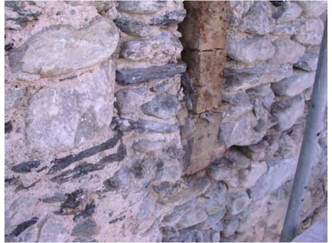
Fig. 9 Façade Nord. Au 1er étage, la maçonnerie (12A) (à gauche) se termine par une tête propre laissant un vide pour l'installation de la pièce en madrier (33) dont ne sont visibles que les têtes saillantes de l'assemblage d'angle.
