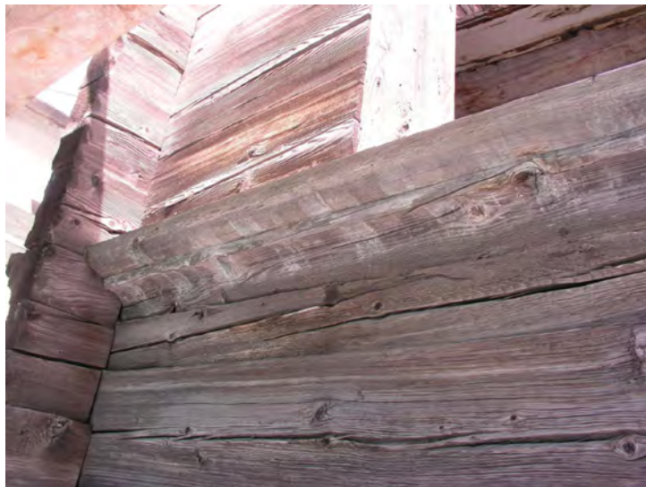
Fig. 17 Façade Ouest. Détails du décors du chalet construit au milieu du XIXe siècle (68).
