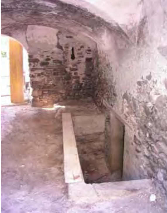
Fig. 5 Passage voûté au niveau du rez, vue vers le Sud. Au fond, la cage d'escalier ; en premier plan, la porte (10), l'accès au sous-sol du Corps Ouest.
