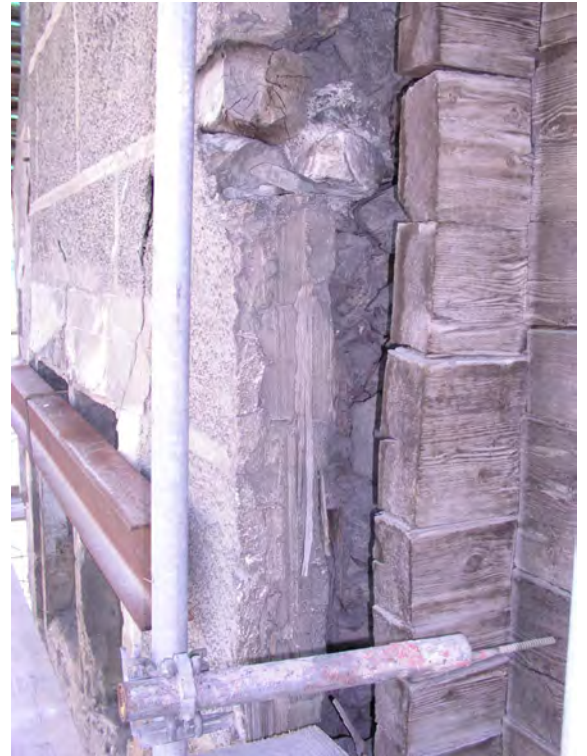
Fig. 11 Façade Nord. Même situation à la limite supérieure du 2e étage. La maçonnerie (12B) (à gauche) se termine par une tête respectant un élément en bois recouvert de tavillons. A droite, l'étage en madrier du XIXe siècle (68).
