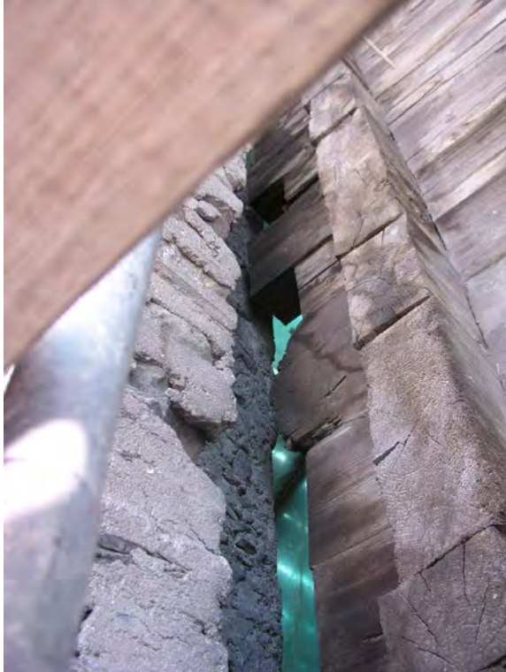
Fig. 12 Façade Nord. Mêmes situation au niveau des combles. La maçonnerie (12C) (à gauche) venait s'appuyer contre des éléments en bois disposés à l'horizontal. A droite, l'étage en madrier plus récent du XIXe siècle (68).
