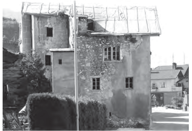
Fig. 31 Vue avant le début des travaux : façade Est. (photo Monuments Historiques).
