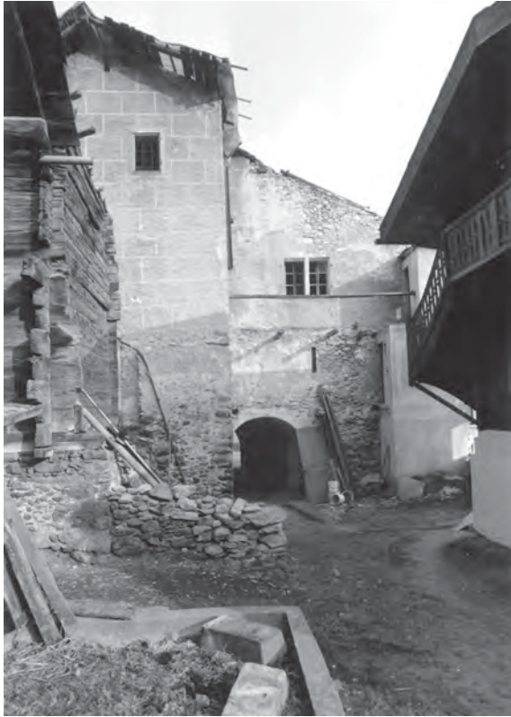
Fig. 30 vue avant le début des travaux : façade Sud. (photo Monuments Historiques).
