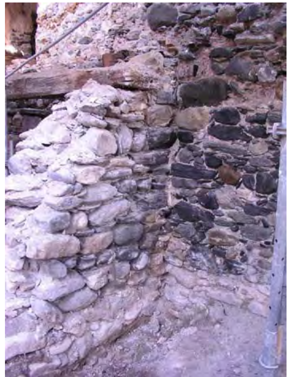
Fig. 2 Détail du socle primitif (1) (à gauche) contre lequel vient buter la base de la cage d'escalier (à droite). Sur l'arasement du socle (1), le sommier (4) sur lequel posait le chalet.
