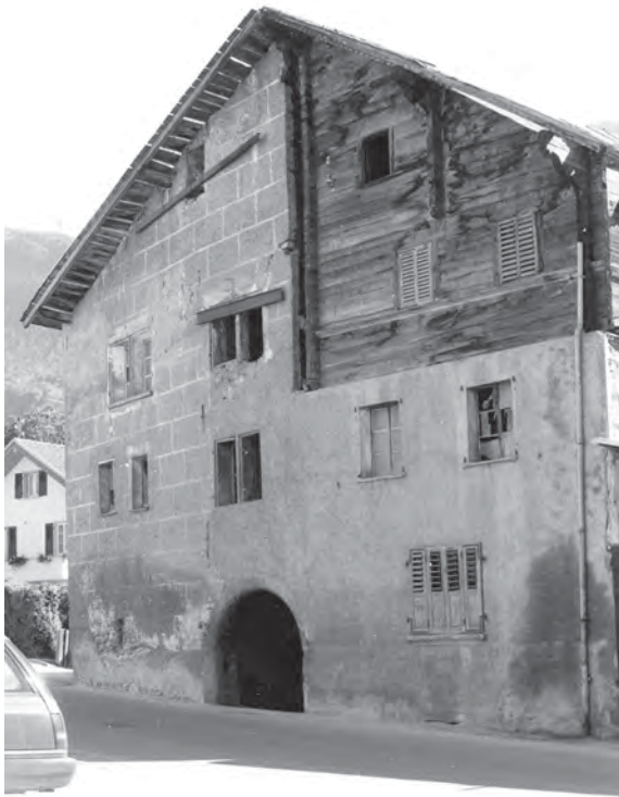
Fig. 23 Façade Ouest, détail de la cheminée. L'enduit encore conservé à la base permet de déterminer la position exacte de l'ancienne toiture.
