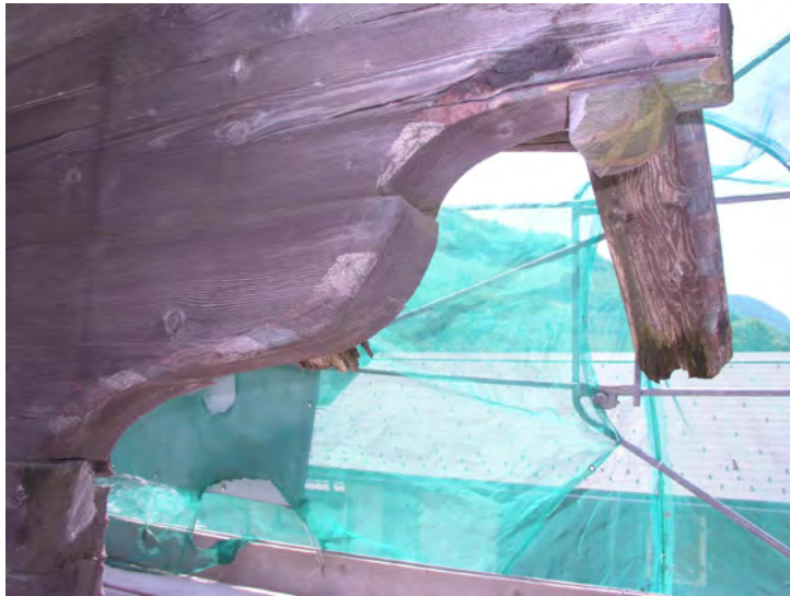
Fig. 16 Façade Nord. Détails du décors du chalet construit au milieu du XIXe siècle (68).
