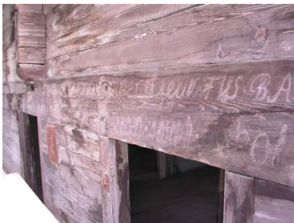
Fig. 14 Façade Nord. Détails du décors du chalet construit au milieu du XIXe siècle (68).
