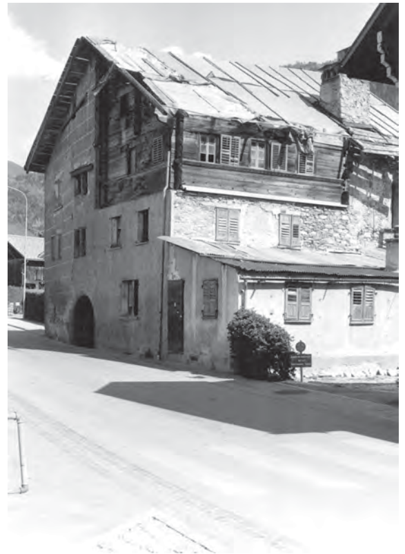
Fig. 24 Vue avant le début des travaux : façade Nord et Ouest (photo Monuments Historiques).
