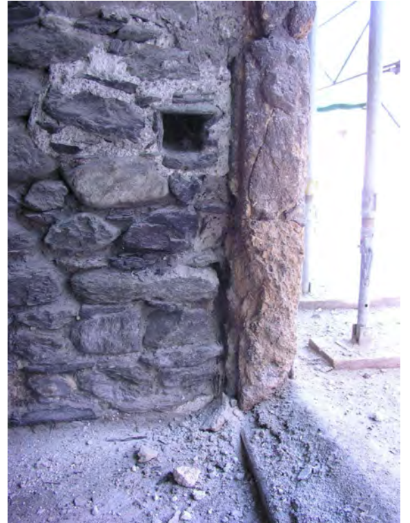
Fig. 20 Passage voûté au rez, portail Nord (70). Détail de l'encoche du piédroit occidental permettant de loger la poutre-verrou.
