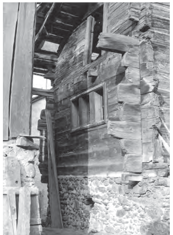
Fig. 29 vue avant le début des travaux : façade Sud du corps Sud. Derrière l'encadrement récent des fenêtres on aperçoit les ouvertures plus petites d'origine. (photo Monuments Historiques).
