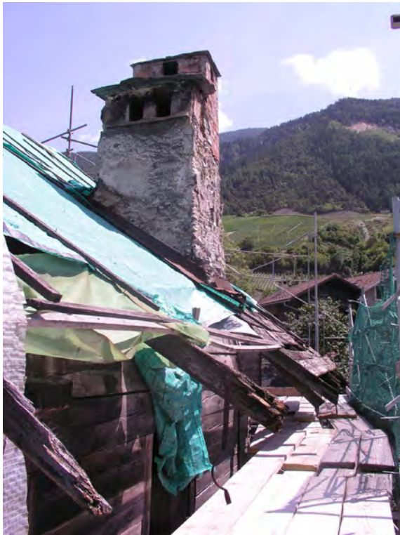
Fig. 23 Façade Ouest, détail de la cheminée. L'enduit encore conservé à la base permet de déterminer la position exacte de l'ancienne toiture.
