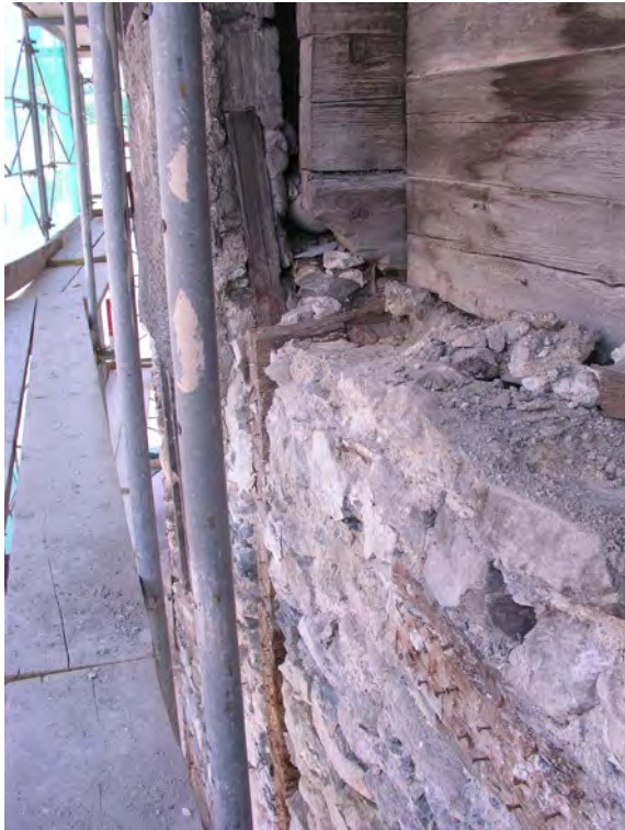
Fig. 10 Façade Nord. Partie inférieure : le madrier (33) dont ne sont visibles que les têtes saillantes de l'assemblage d'angle. Au 2e étage : la maçonnerie (12B) (en arrière plan) se terminant par une tête respectant un élément en bois recouvert de tavillons. Ces tavillons ont laissé leur négatif et sont parfois restés collés dans le mortier du mur. En haut à droite : l'étage en madrier du XIXe siècle (68).
