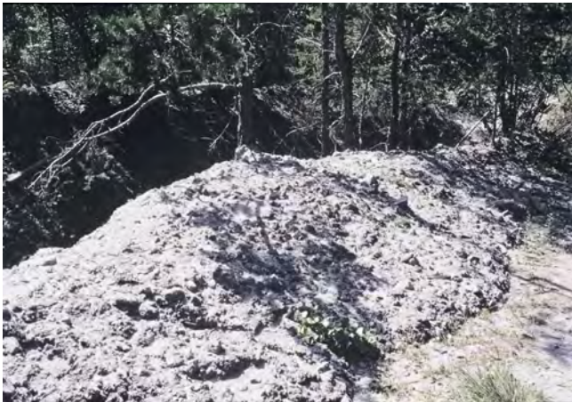
Fig. 70 : Brig-Glis/Holzji, août 1995 : levée de boue dans la partie rectiligne du chenal.
