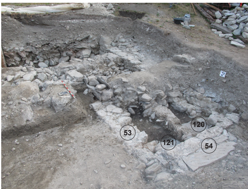
Fig.14 Bagnes, Villette. Façade occidentale du bâtiment B2. Au premier plan, les murs 54 et 53 construits sur les dalles 120 et 121. Ils ont probablement servi de soubassement pour un escahier extérieur en bois. Vue en direction du nord-ouest.
