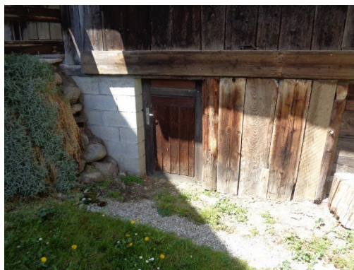
Cave côté Sud-Est – Rez inférieur
