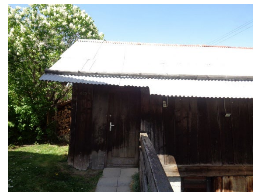
Dépôt côté Sud-Est – Rez supérieur
