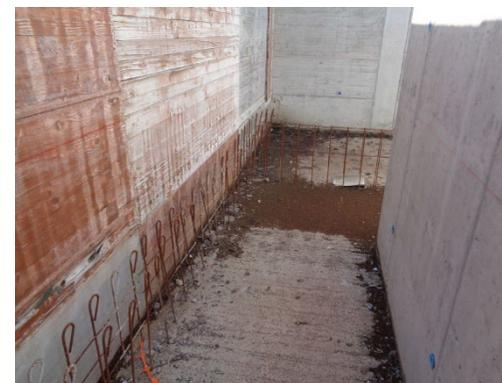
Façade avec fers à béton apparents
