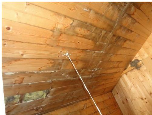
Infiltration d'eau ; Toiture
