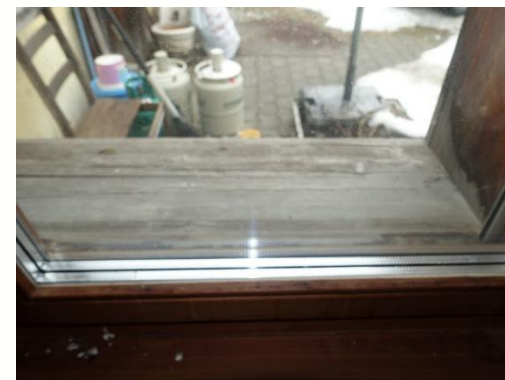
Fenêtre en bois avec vitrage isolant triple
