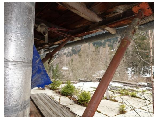
Toiture à renforcer ou démonter et terrasse / toiture annexe à contrôler
