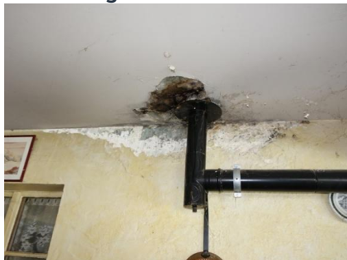
Etanchéité toiture annexe à assainir
