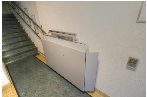
Rampe d'escalier d'accès à l'ascenseur
