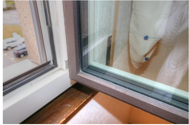
Fenêtre PVC/métal/vitrage triple
