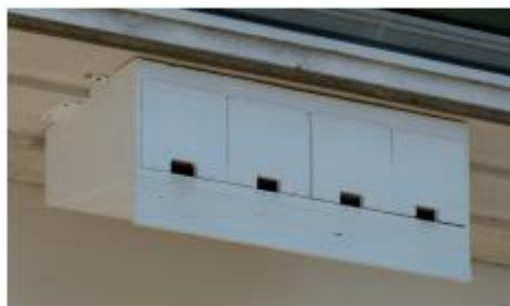
Illustration 3 : Les martinets noirs adoptent également d'autres types de nichoirs, et les modèles placés directement les uns à côté des autres ne posent aucun problème. Les planchettes à charnières et équipées d'aimants permettent une fermeture aisée pour l'hiver en s'aidant d'une tige télescopique (Photo : Hans Schmid).
