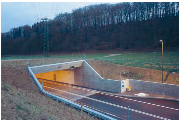
Tunnel de Horental, Küttigen/Aarau, 2011
