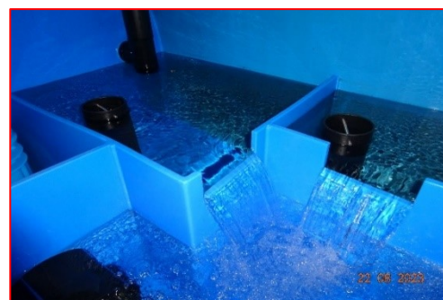
12 : Chambre de réunion d'eau de source. © SCAV
