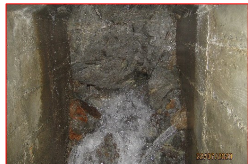
15 : Galerie de captage avec drains latéraux. © SCAV
