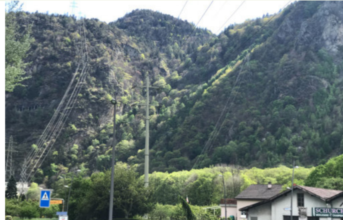
Vernayaz - Verschiedene Hochspannungsleitungen
