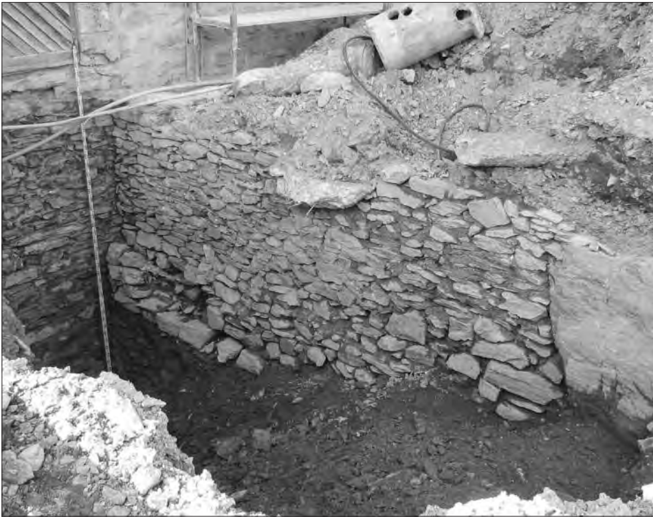
Fig. 4 – Leuk-Stadt, Turmmatte. Paroi nord du même bâtiment. La maçonnerie est appuyée, à gauche, contre la façade du Bischofsschloss; à droite, elle englobe un bloc erratique pris dans la moraine.
