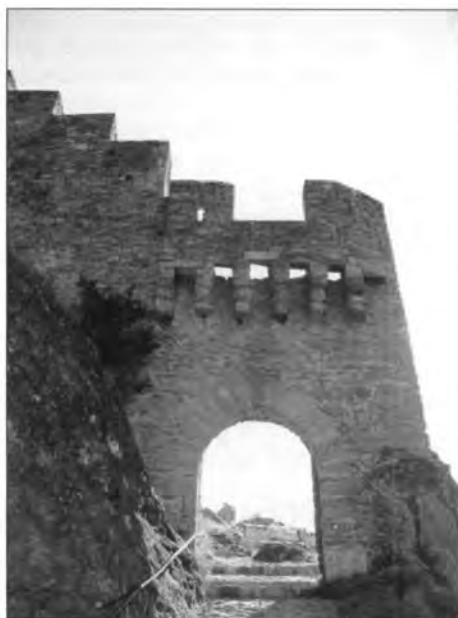
Fig. 19 – Sion, colline de Tourbillon. Les mâchicoulis au-dessus du portail remplacent la tour porche primitive.
