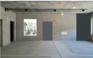
Salle de visite 015 Bâtiment A
