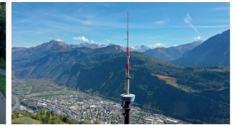
Photographie réalisée au drone autour d'une antenne au dessus de Marigny
