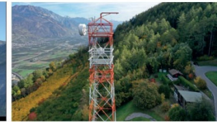
Photographie réalisée au drone autour d'une antenne au dessus de Marigny
