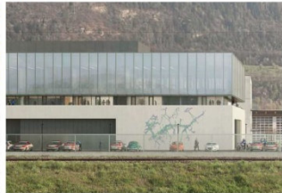
Mise en situation sur la façade principale du bâtiment
