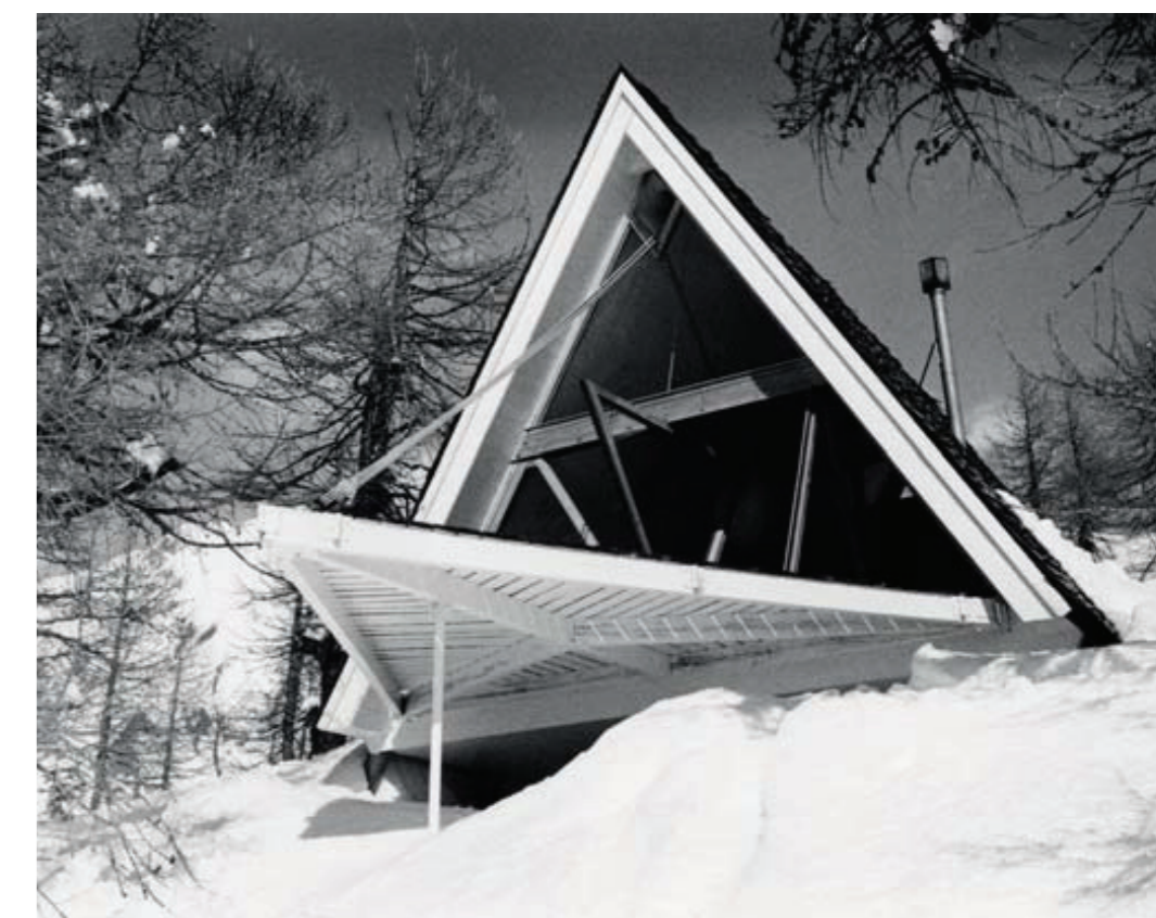
ROSSWALD Situé à 2000 mètres d'altitude, le Trigon (Heidi et Peter Wenger, 1956), représentait pour ces architectes, un objet de recherche autant qu'un lieu de retraite. Le toit, élément clé du bâtiment, définit sa forme et son espace intérieur*. ACM/EPFL - FONDS HEIDI ET PETER WENGER
