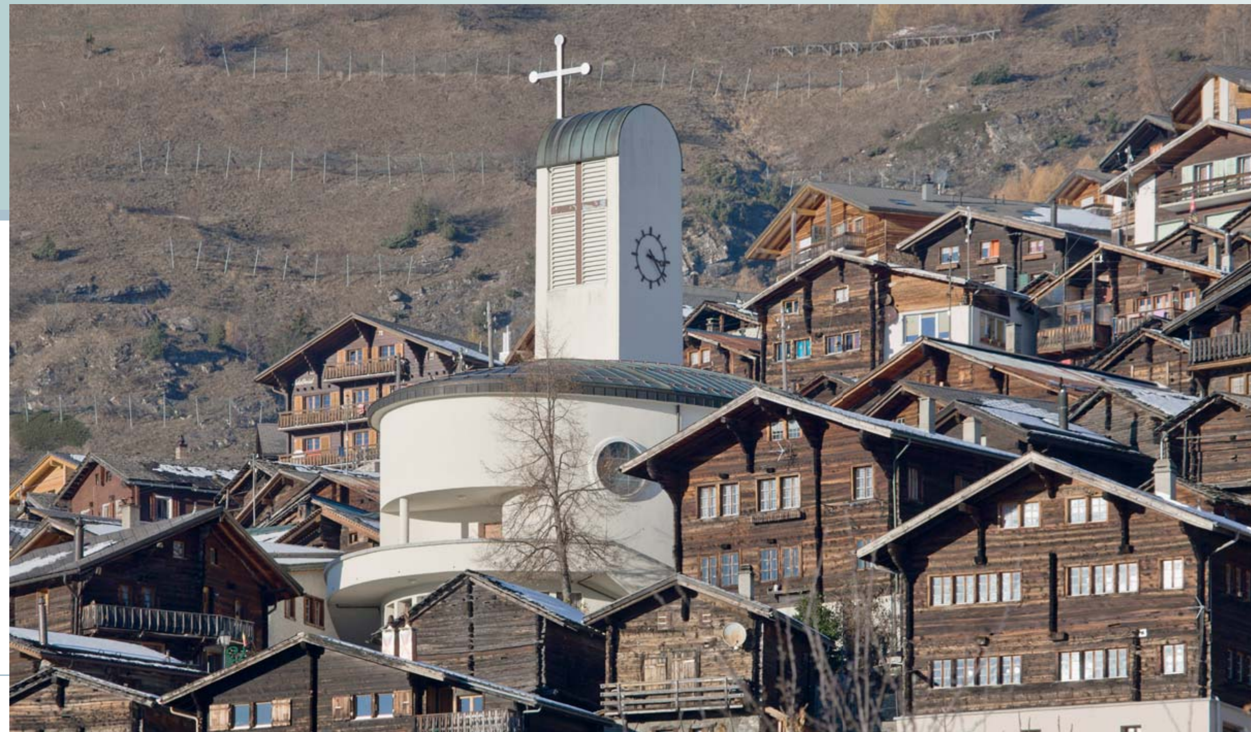
ALBINEN L'église Saint-Nicolas-de-Flüe (Amédée Cachin, 1960) est implantée au sein d'un village compact et homogène, dans un site escarpé. Avec ses lignes douces et arrondies, elle s'intègre sans heurts.* ETAT VALAIS/SIP © THOMAS ANDENMATTEN
